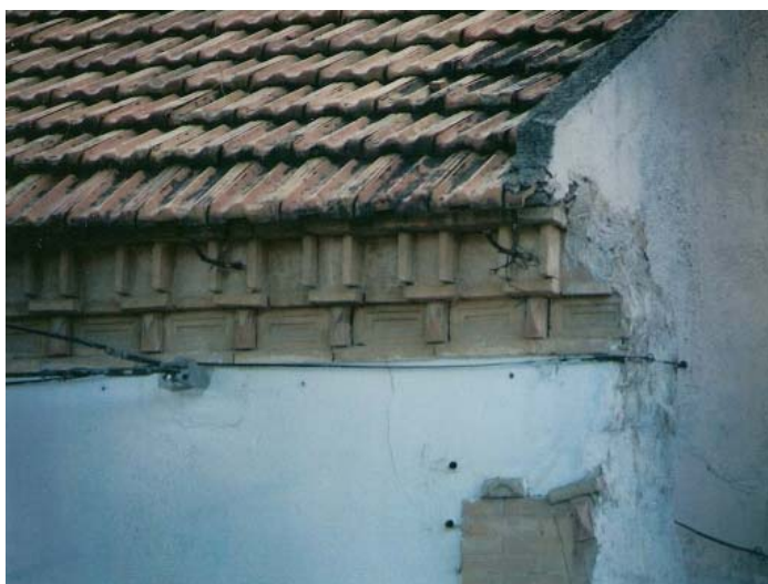
0402 – Detalle de la cornisa del almacén (tipo 36) hasta la parte ya derribada (18-9-2000)
