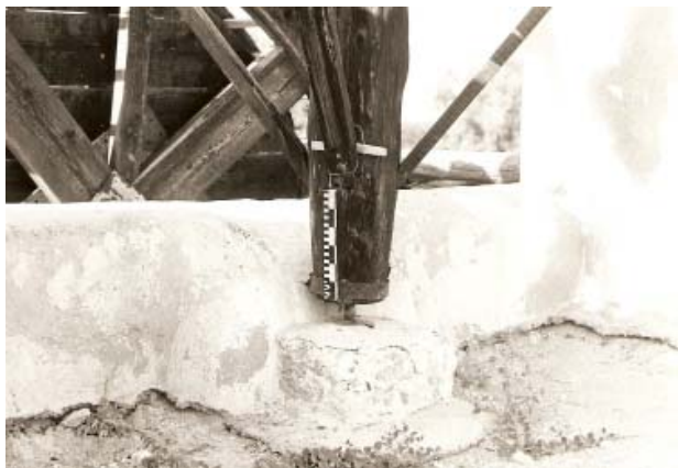
0204 – Eje de la aceña y colocación del tejuelo entre los postes (15-9-1979)
