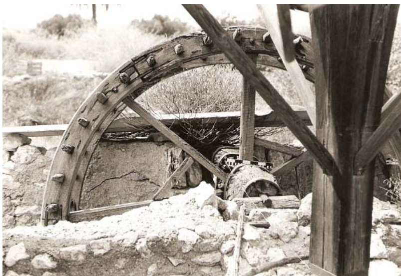
0211 – Rueda o andaraje sin los arcaduces. A la derecha, el eje o "árbol" de la aceña (15-9-1979)
