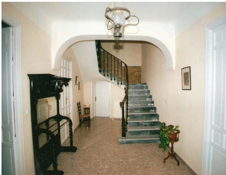
0243 – Vestíbulo con acceso a varias dependencias y arranque de la escalera de bóveda tabicada. Existían unos pavimentos originales de loseta hidráulica sustituidos ahora por terrazo (20-9-2000)
