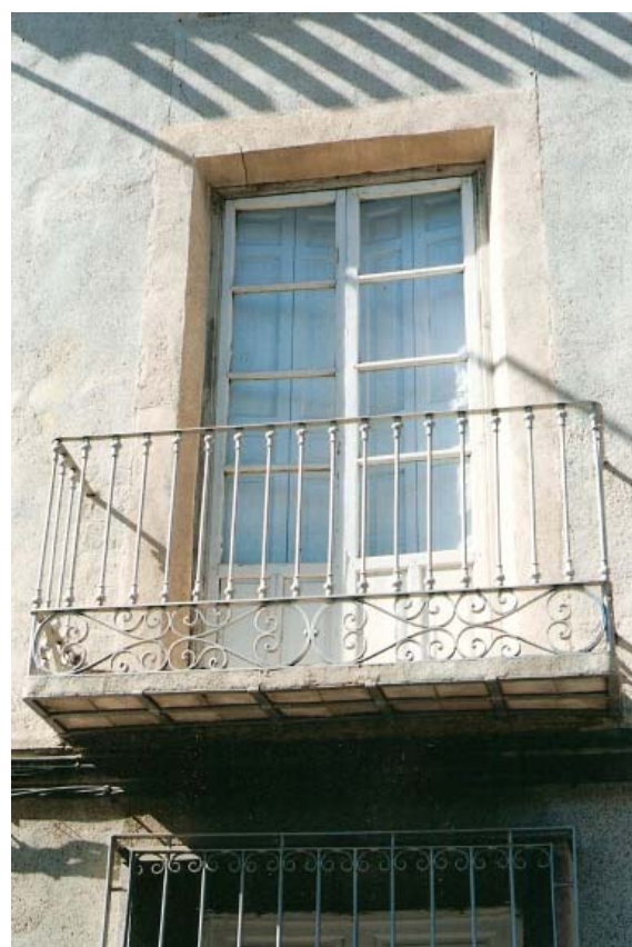
0439 – Edificio nº 20. Tipología característica (tipo V) con fajones en huecos casi desaparecidos por sucesivos revestimientos de la fachada (tipo V) (15-8-2000)
