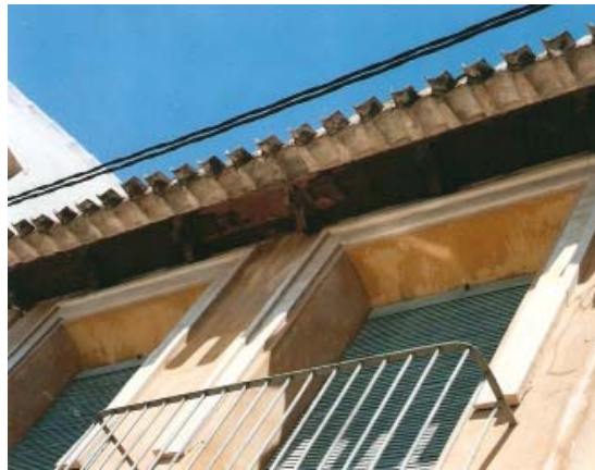
0436 – Edificio nº 17. Alero de madera con canecillos (tipo 2) y hueco de balcón con faja y sencillas molduras (27-8-2000)
