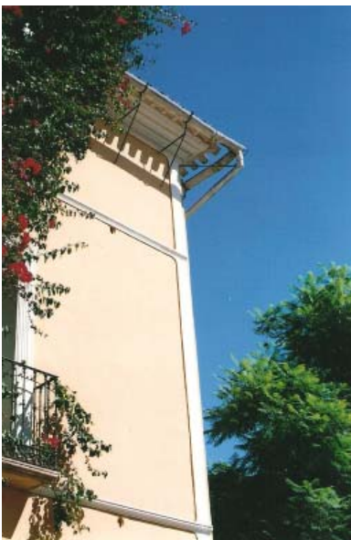
0277 – Detalle del cornero o esquina, la cornisa (tipo 29) y las canaleras de cinc sujetas con los fiadores o escarpiadores (22-8-2000)
