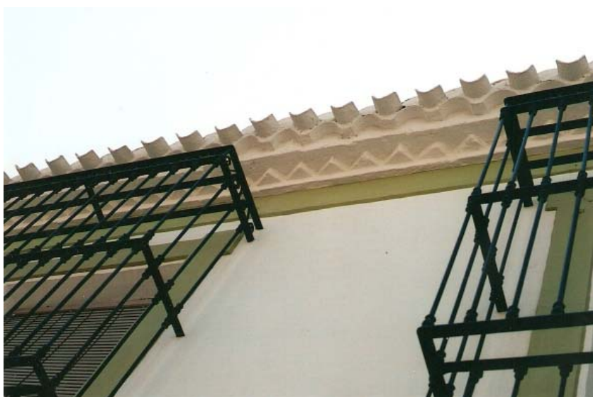
0356 – Edificio nº 11. Detalle del alero (tipo 21) y de las rejas (tipo B) superpuestas a los balcones (13-8-2000)
