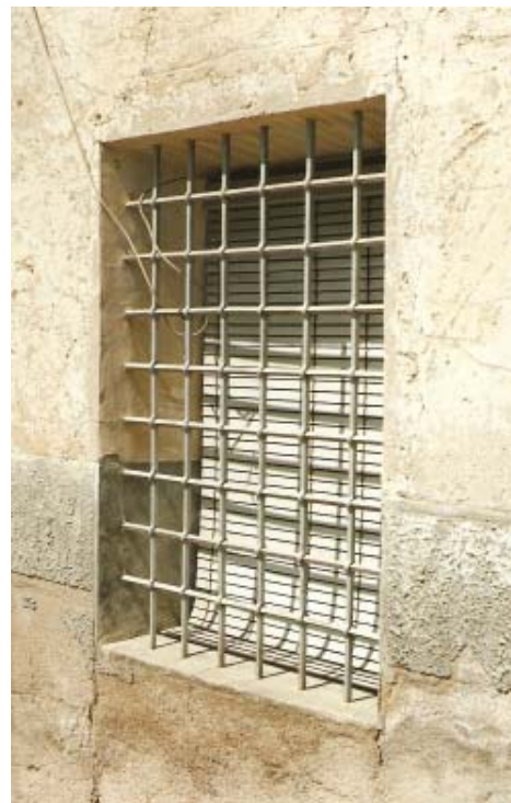
0422 – Edificio nº 8. Reja en la planta baja (tipo A) (18-8-2000)
