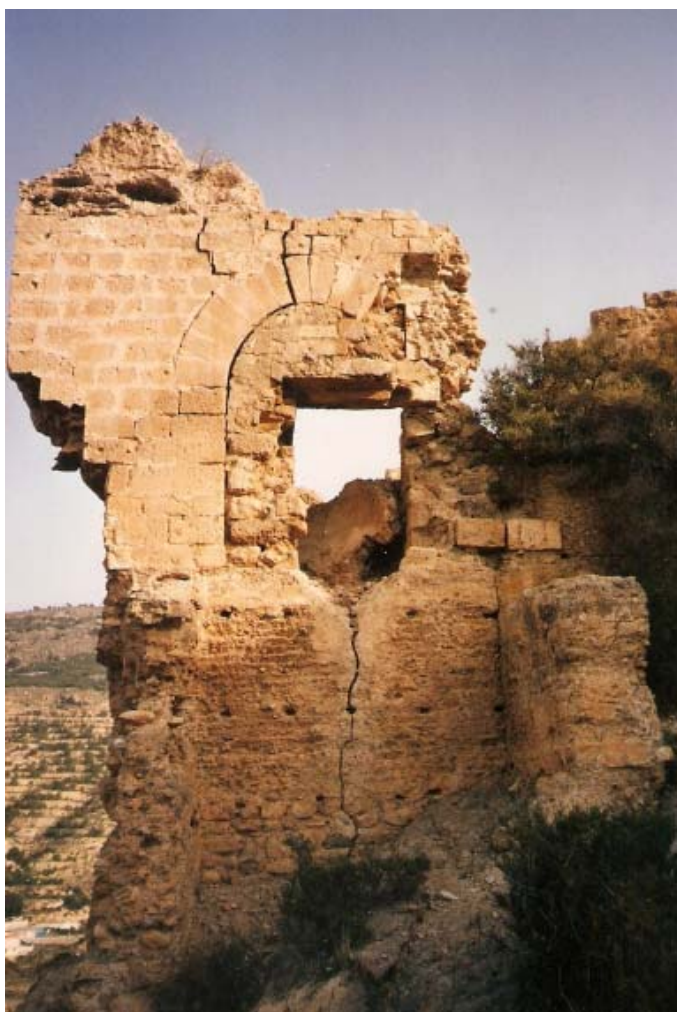
0161 – Restos de las últimas reparaciones del castillo. Esta torre en la parte baja de la alcazaba se acondicionó para uso residencial sobre la base de las murallas más antiguas (marzo 2000)
