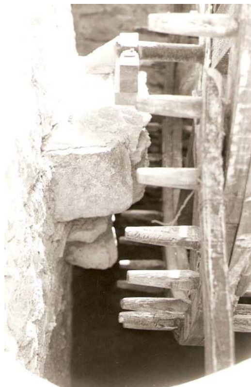
0213 – Andaraje con el apoyo del mástil o eje de esa rueda (15-9-1979)
