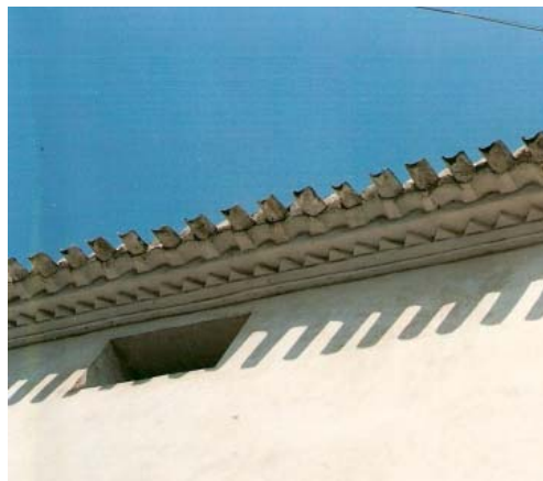
0367 – Edificio nº 16. Detalle del alero con cornisa simple (tipo 21) (13-8-2000)
