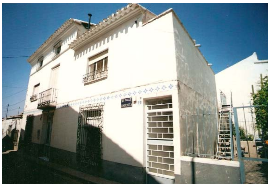
0282 – Edificio nº 2. Tipología característica (tipo V). Vivienda que mantiene sus volúmenes con algún adosado, presentando alteradas la cerrajería de algunos huecos (15-8-2000)
