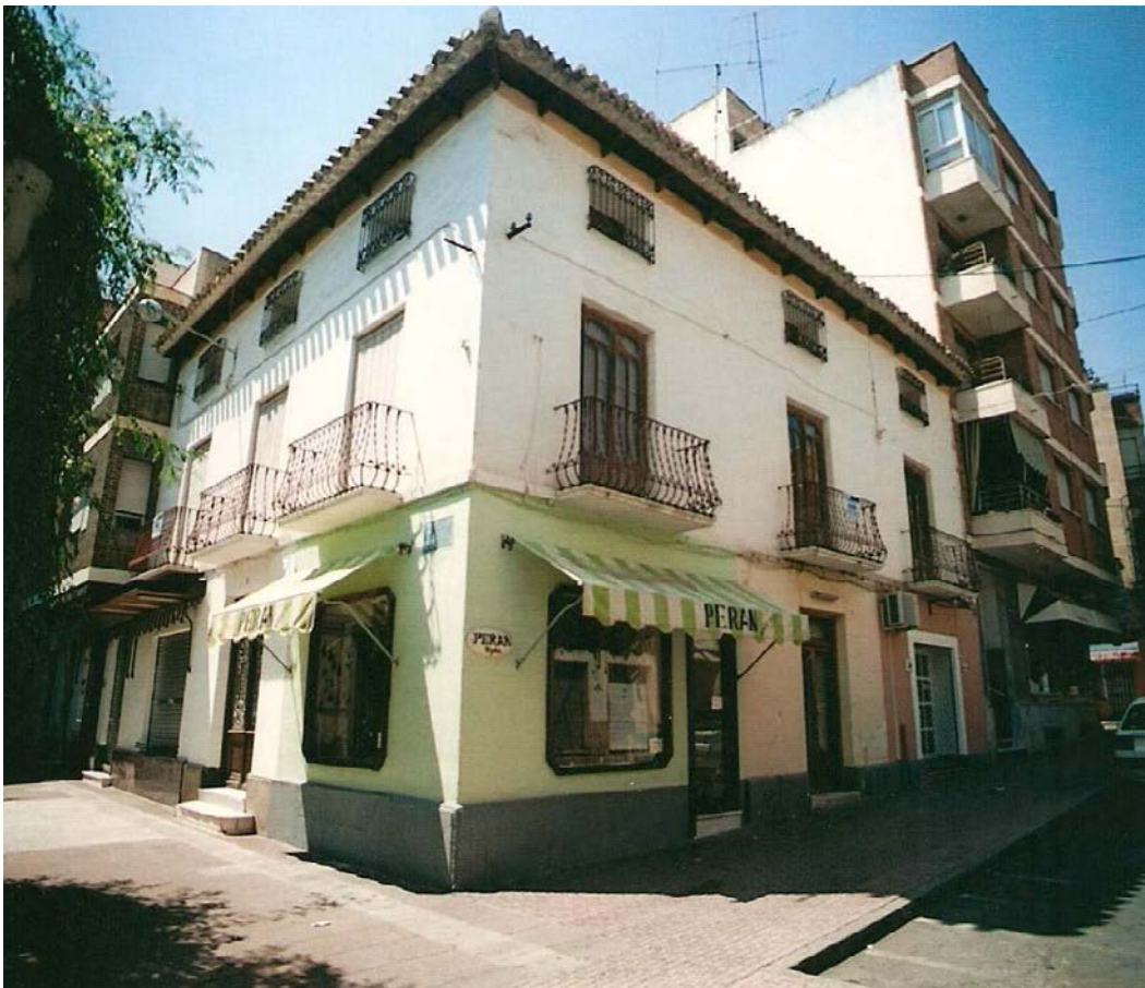
0492 – La casa-torre de Josefa García, flanqueada por uno de sus lados por un edificio de cinco plantas, signo clásico del erróneo concepto de progreso de décadas pasadas; y por el otro lado, por un edificio de negativo y lamentable diseño. Toda la planta baja de la edificación aparece alterada por nuevos huecos mientras que las plantas superiores se han mantenido poco alteradas (13-8-2000)
