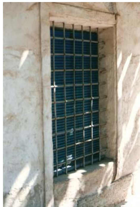
0327 – Edificio nº 6. Ventana con fajón y reja. Arranque de muros de sillares de cantería (tipo A) (22-8-2000)
