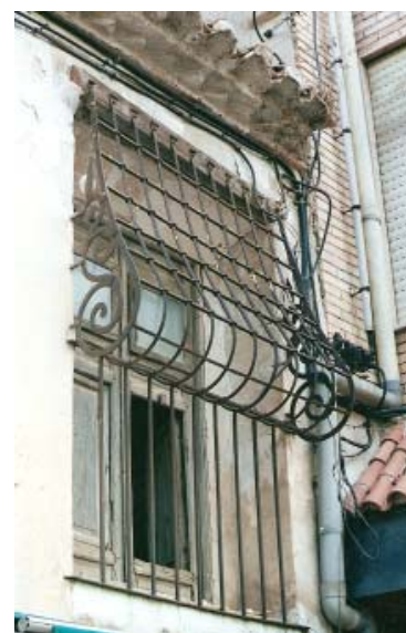
0478 – Edificio nº 3. Reja de "buche de paloma" de la planta superior (17-9-2000)
