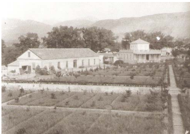
0392 – Casa, almacén y huerto de Lorenzo Rubio. Por detrás de las edificaciones sobresalen los olmos de la rambla de don Diego. Todas las construcciones ya fueron derribadas y sobre su solar no se ha levantado ningún edificio de viviendas, solamente edificios de dotaciones sociales y zonas ajardinadas públicas. Posiblemente nos encontremos ante un caso único (archivo Mateo García, Ángel Martínez, años 10)
