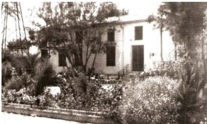
0398 – Edificación junto al almacén. Delante de ella, la torre que sustentaba un depósito de agua para poder obtener presión en las tuberías (archivo M. García, años 20 ó 30, autor desconocidos)
