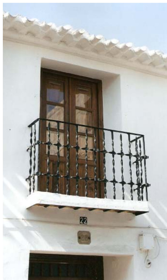
0226 – Edificio nº 22. Balcón con repisa de plantilla metálica y loseta hidráulica. Cerrajería de plantilla trenzada (tipo C) con carpintería y fachada muy cuidadas (18-8-2000)
