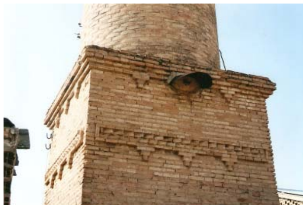
0455 – Pedestal de la chimenea, inusualmente alto (5-6-2001)
