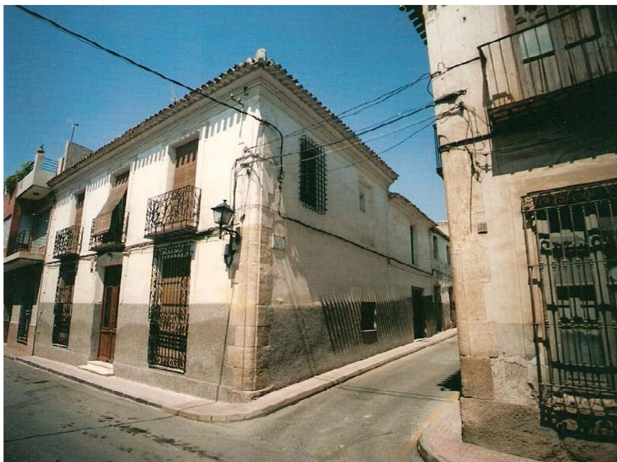
0358 – Edificio nº 12. Se aprecia el acabado con adrajadas de sillares en la esquina, cornero o cornijón del edificio. Zócalo del edificio igualmente de sillería (13-8-2000)
