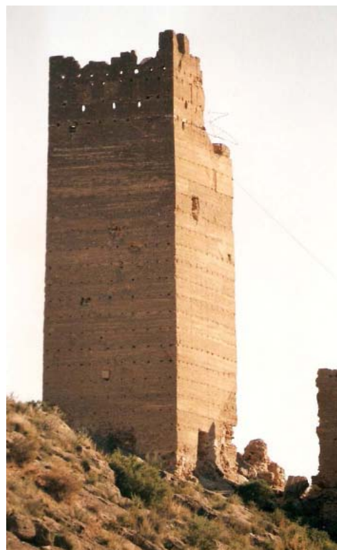
0164 – Alzado norte de la torre. Es la única parte en donde todavía es posible conocer la culminación de la construcción y la existencia de aspilleras en el penúltimo nivel, así como las almenas de la parte superior (marzo 2000)
