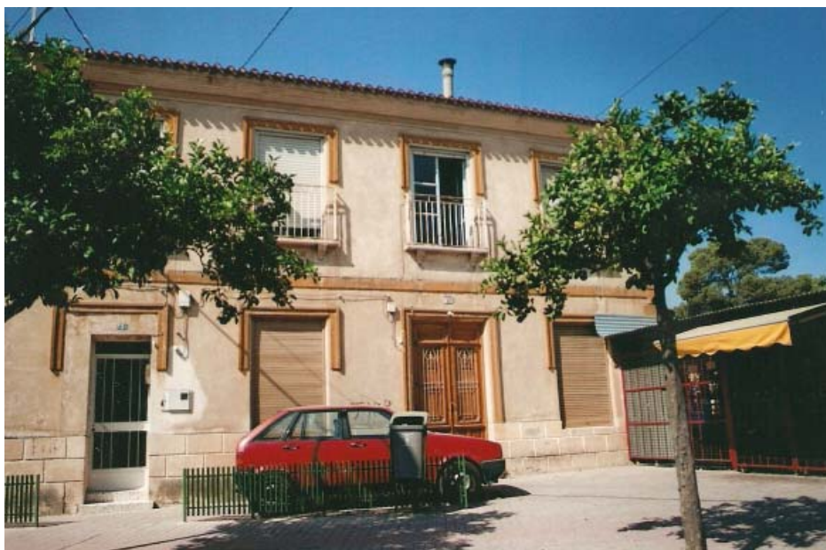
0258 – Edificio nº 12. Los huecos exteriores aparecen con adornos de fajas. Los balcones tienen la repisa de piedra artificial con pequeñas ménsulas del mismo material (15-8-2000)
