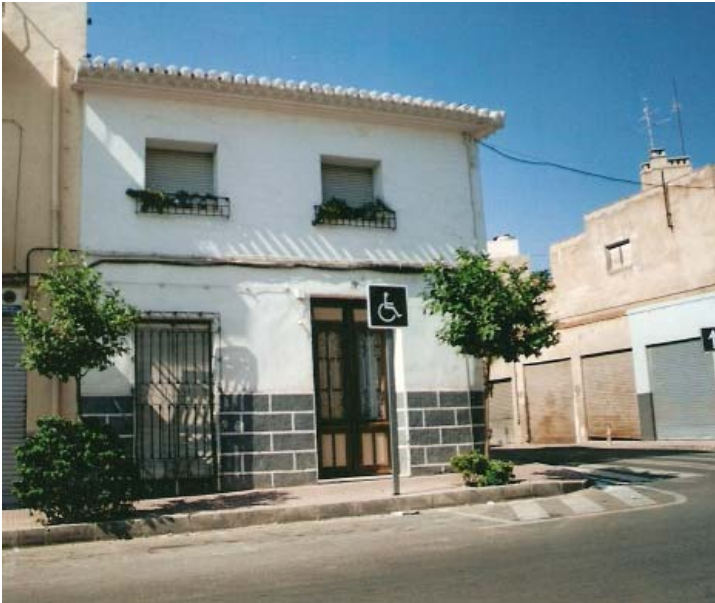
0426 – Edificio nº 2. Se mantiene el alero de la antigua construcción. Puerta de ventanillos de mayores dimensiones de lo normal (15-8-2000)
