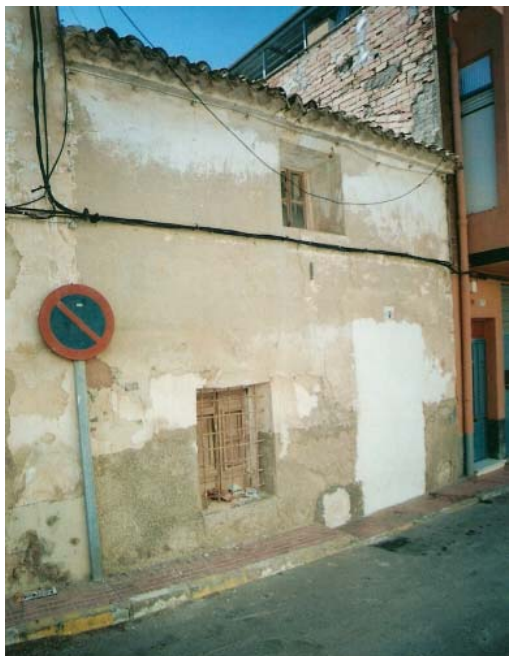
0304 – Edificio nº 4. Tipología característica (tipo I). Se aprecia en los dinteles de la ventana de la planta alta el grosor de los muros de mampostería (16-9-2000)
