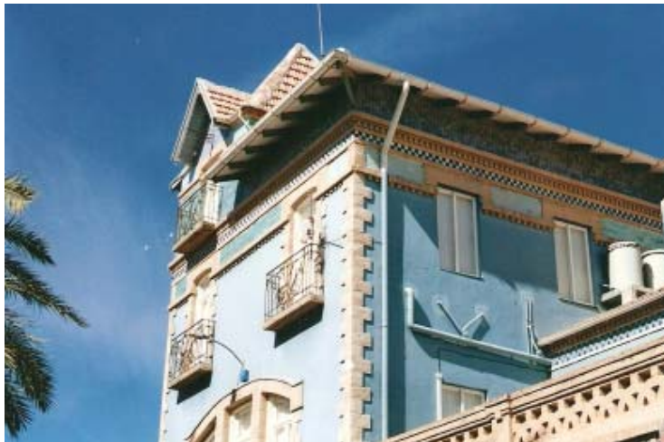
0235 – A la planta superior se le adosa la torreta con la originalidad de la cubierta a cuatro aguas con frontón a la fachada principal y tejas planas o alicantinas (20-9-2000)
