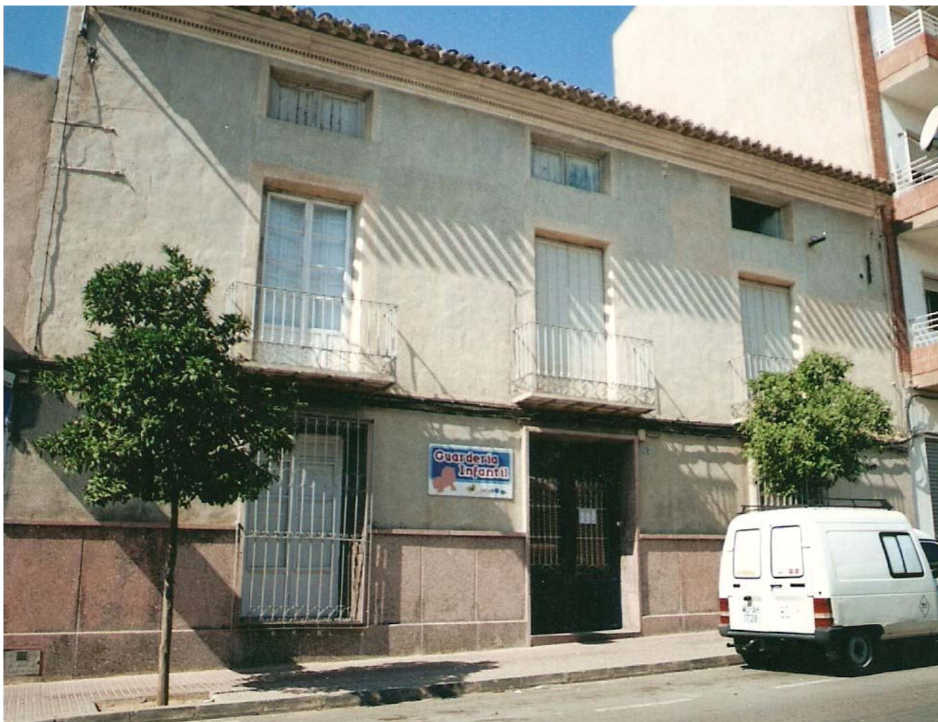
0439 – Edificio nº 20. Tipología característica (tipo V) con fajones en huecos casi desaparecidos por sucesivos revestimientos de la fachada (tipo V) (15-8-2000)
