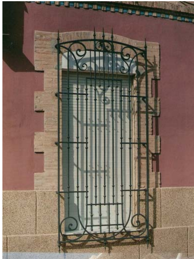
0238 – Cerrajería modernista tardía simple con elementos clásicos en los remates y fajones de ladrillos (20-9-2000)
