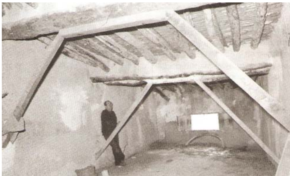
0380 – Edificio nº 28. Cámara o camaranchón. Apuntalamientos de vigas de carga de la cubierta (archivo Mateo García, fecha y autor desconocidos)
