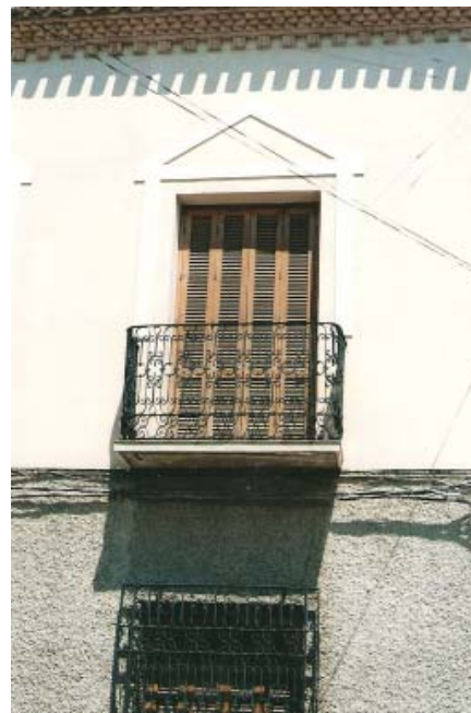
0431 – Edificio nº 5. Balcón con faja y frontón (27-8-2000)
