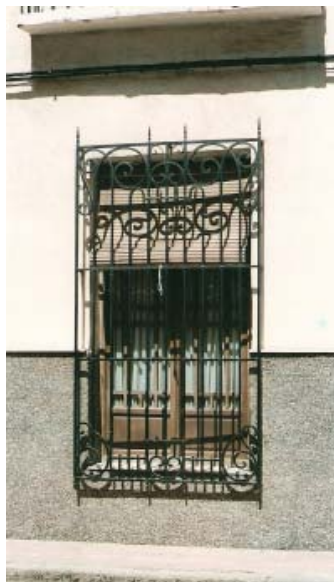
0366 – Edificio nº 16. Reja de ventana de la planta baja (22-8-2000)
