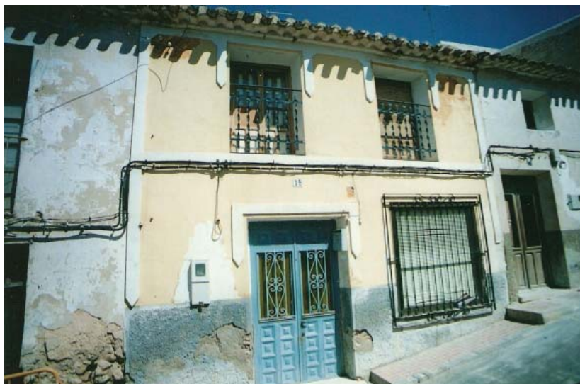
0305 – Edificio nº 15. Construcción interesante en cuanto a su composición (tipo II), pero muy alterada en lo referente a huecos (16-9-2000)
