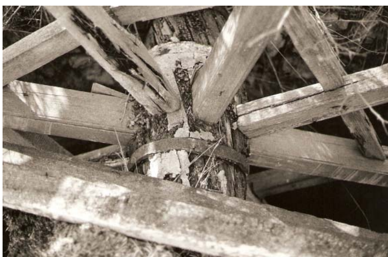
0212 – Mástil o eje de la rueda andaraje o de arcaduces y su encuentro con las cruces (15-9-1979)
