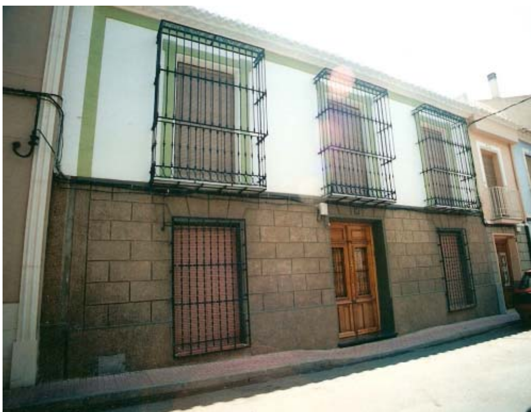
0355 – Edificio nº 11. Tipología original característica pero ya muy alterada (tipo V). Cerrajería de diversas procedencias (tipos B y C) y revestimientos poco adecuados. Puerta tradicional de ventanillos (tipo F) (13-8-2000)
