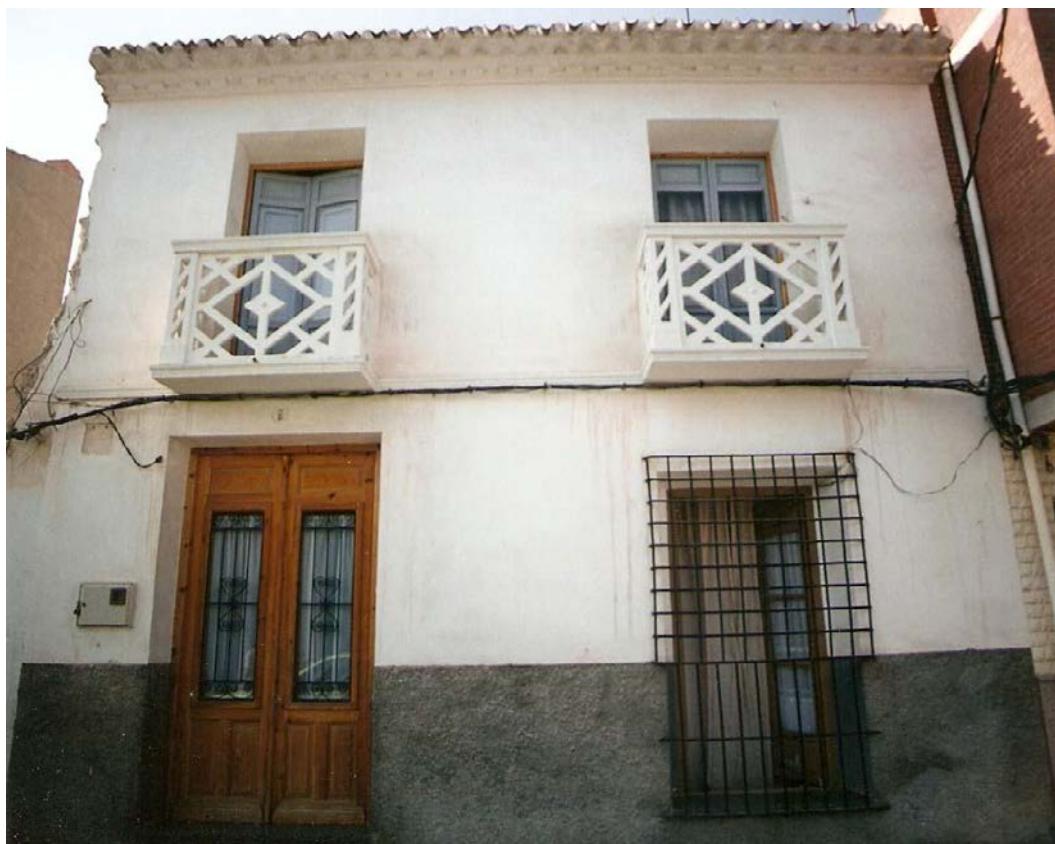
0308 – Edificio nº 6. Tipología característica (tipo V). Balcones de piedra artificial adosados posteriormente. Puerta de ventanillos (tipo F) sustituida y rejas de dos cuerpos (tipo A) (18-8-2000)
