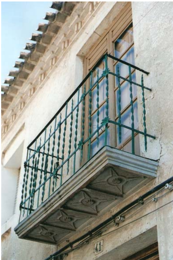
0263 – Edificio nº 41. Balcón con repisa de piedra artificial y cerrajería simple de plantilla trenzada (tipo C) (27-8-2000)
