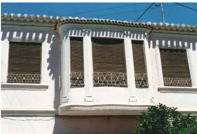
0444 – Edificio nº 21. Voladizo cerrado con elementos decorativos de influencia clásica (27-8-2000)
