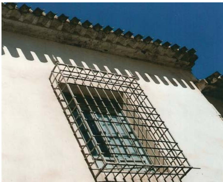
0287 – Edificio accesorio. Reja (tipo A) (22-8-2000)
