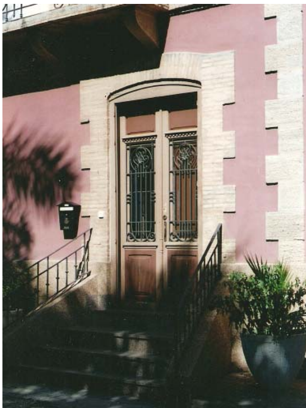
0237 – Acceso a la vivienda. Puerta de ventanillos con rejos y contraventanas clásicas de la época (tipo F) sobre escalinata. Fajones y esquinas con "brecas o redientes" (20-9-2000)
