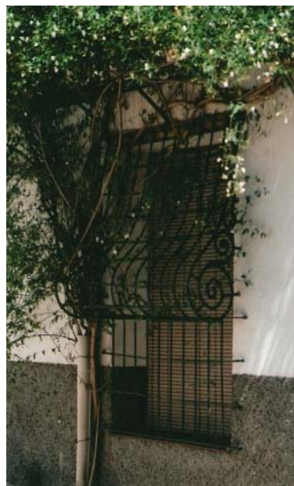
0386 – Edificio nº 32. Reja de "buche de paloma" en la fachada al Paseo de los Mártires (22-8-2000)
