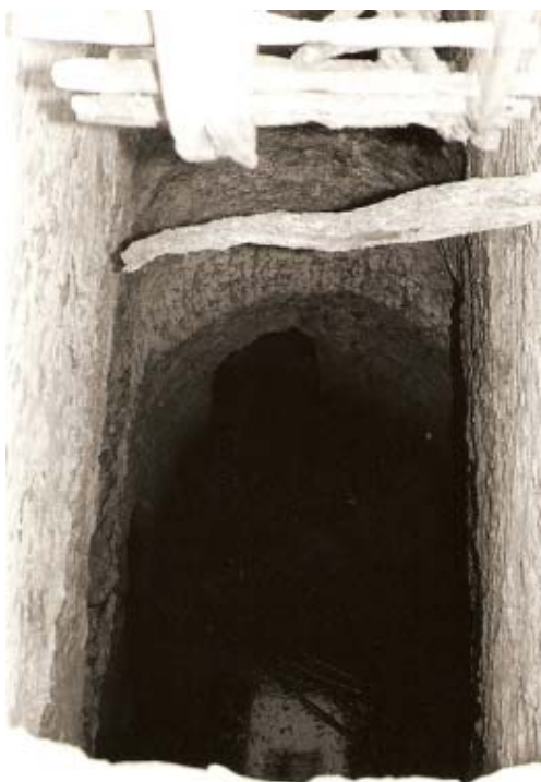
0217 – Pozo de la aceña. En el fondo se distingue la boca de una galería realizada para incrementar la captación de aguas (15-9-1979)
