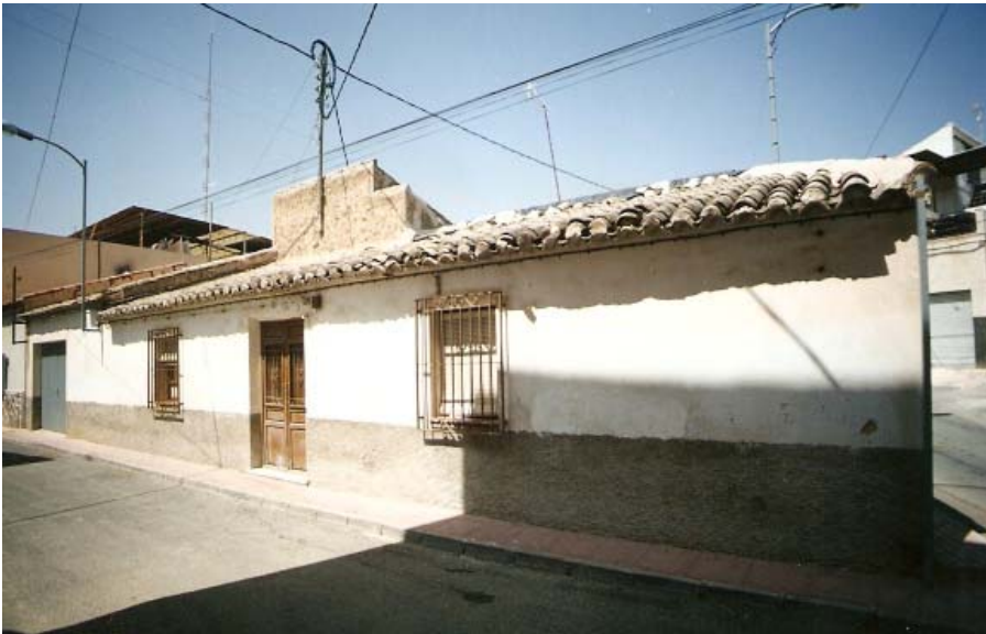
0299 – Edificio nº 2. Tipología característica (tipo III) con puerta sustituida (de tipo B a tipo F) y cerrajería añadida. Antigua yesera (18-8-2000)
