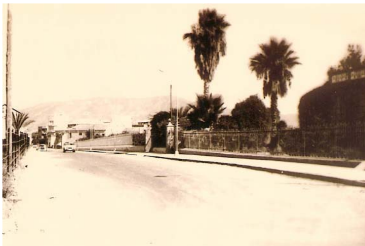
0331 – La hoy avenida de la Constitución y entonces salida de la carretera hacia Mula. A la derecha la cerca de la propiedad de Lorenzo Rubio, e incluso se distingue la silueta de la esquina de su casa, que pocos años después caería bajo la piqueta. A la izquierda la cerca de alambre del huerto de los Artero, hoy plaza de la Constitución (Manrique, hacia 1964)
