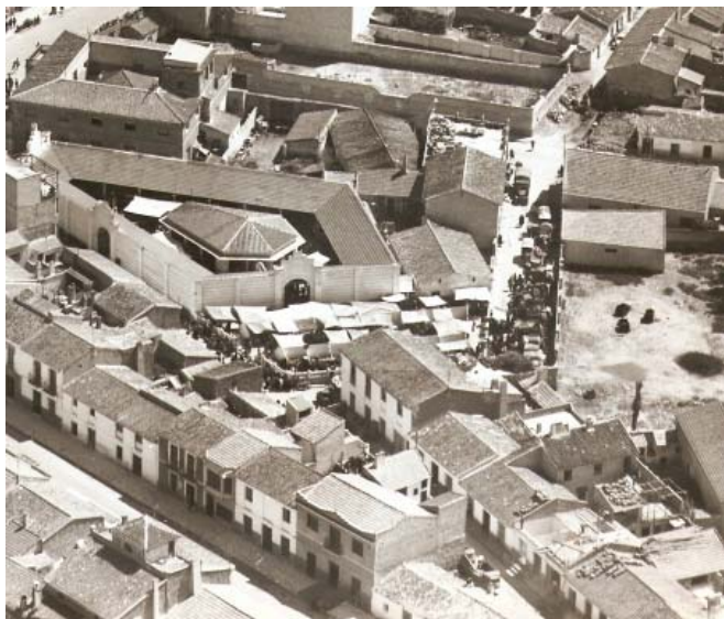
0099 – Es día de mercado y eso se advierte en esta fotografía de la parte trasera de la Plaza de Abastos en donde se ubica un mercado de dimensiones bastante más reducidas que el actual. Se están haciendo los cimientos del edificio que luego albergaría al bar El Chaleco y en la zanja se distingue a un albañil trabajando. Al otro lado de la calle de Los Pasos, y dando fachada a la Avda. Bastarreche, está el solar que ocupaba parcialmente la ermita del Paso Jesús con su extraño muro de cerramiento con huecos clausurados cuyo origen se desconoce (Paisajes Españoles 15-5-1962)
