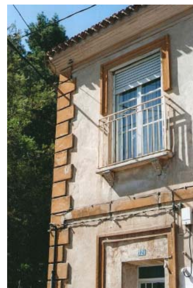
0259 – Edificio nº 12. Falsos sillares en esquina formando adarajas o "redientes" y cornisa de molduras (tipo 2). Se aprecia el tipo de ménsula usado para los balcones y las fajas adosadas a los huecos (27-8-2000)
