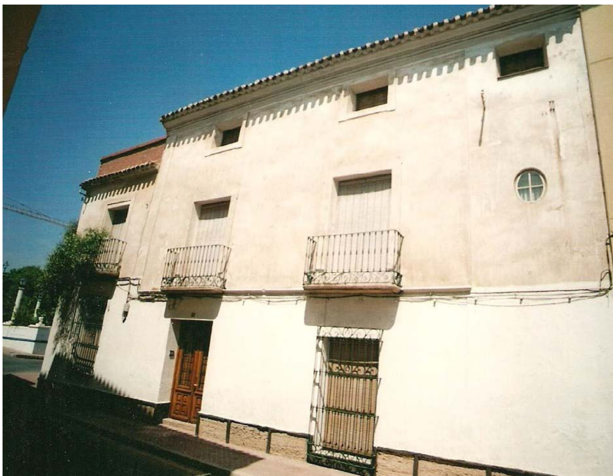
0383 – Edificio nº 32. Casa de Bosque-Hermosa. Ya derribada. Presenta un volumen acoplado hacia la rambla, en antiguo patio. Tiene la singularidad del desplazamiento de la escalera. Los muros de cerramiento apoyan sobre base de sillares de cantería (13-8-2000)
