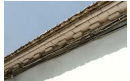
0300 – Edificio nº 16. Alero muy simple (tipo 11) por superposición de ladrillos (18-8-2000)
