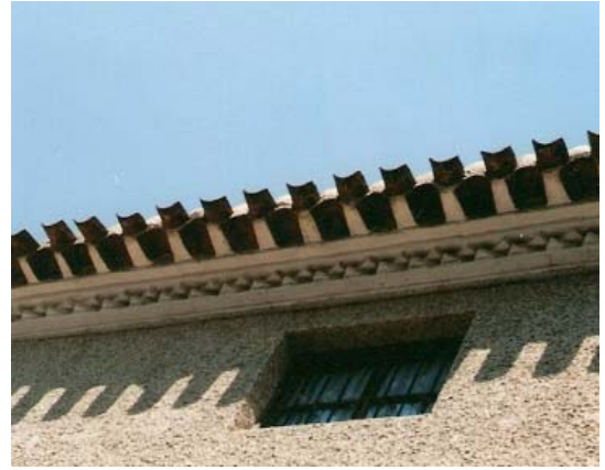
0351 – Edificio nº 8. Cornisa simple (tipo 23) (13-8-2000)
