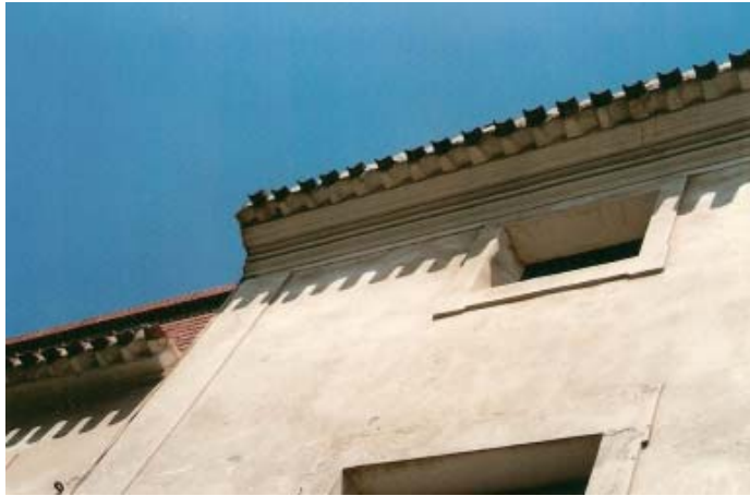
0388 – Edificio nº 32. Aleros y cornisas (tipo 40) correspondientes a los dos cuerpos de la edificación (13-8-2000)
