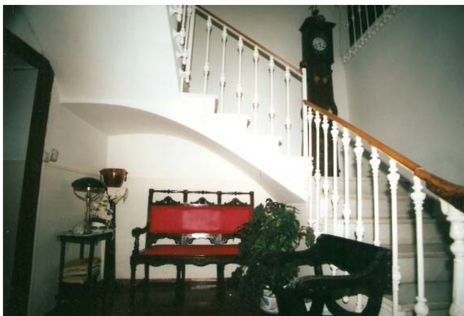
0372 – Edificio nº 16. Escalera de bóveda y barandilla de fundición (1-12-2001)
