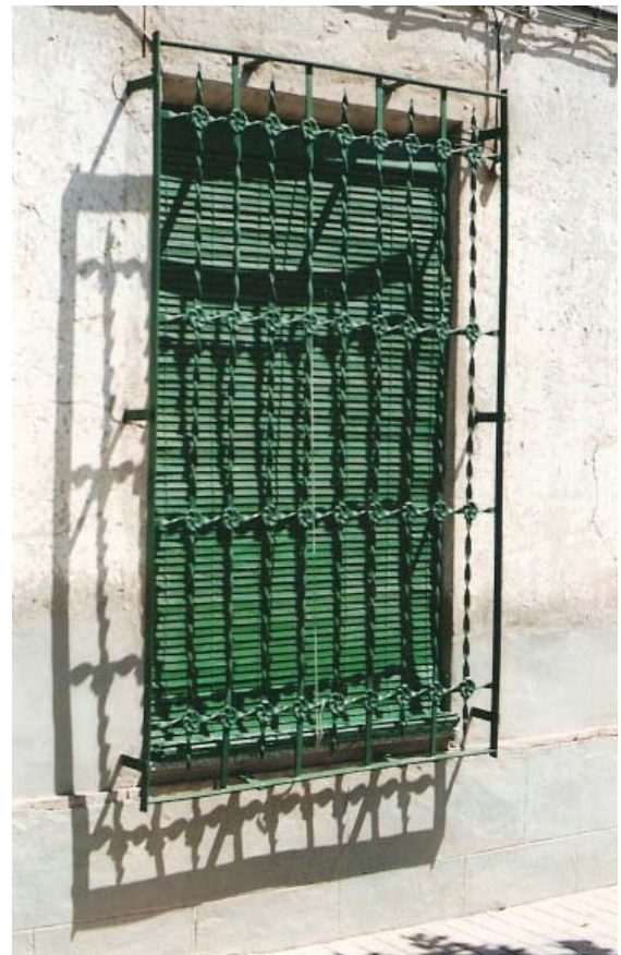
0264 – Edificio nº 41. Reja de plantilla trenzada (tipo C) (27-8-2000)
