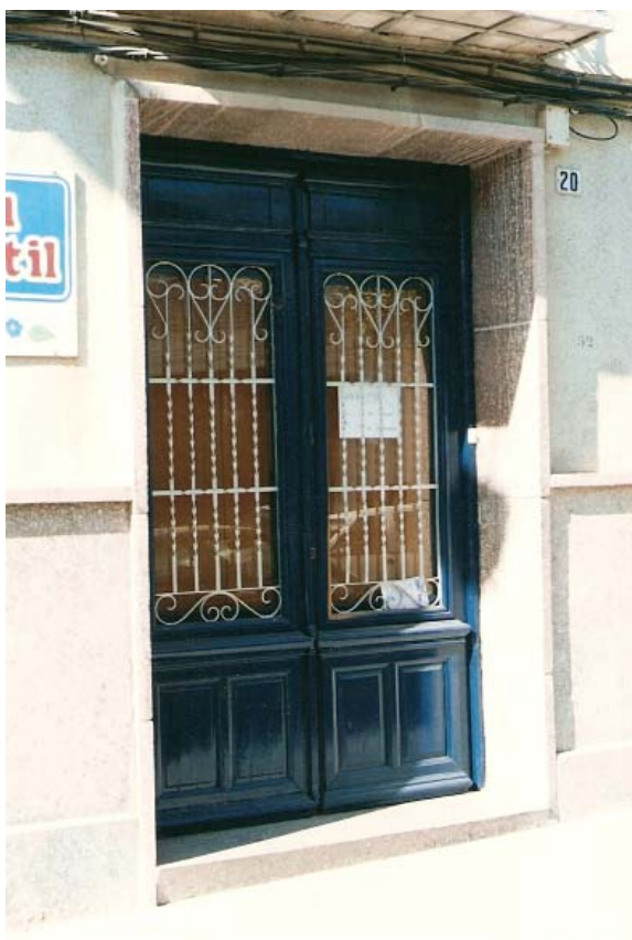
0439 – Edificio nº 20. Tipología característica (tipo V) con fajones en huecos casi desaparecidos por sucesivos revestimientos de la fachada (tipo V) (15-8-2000)
