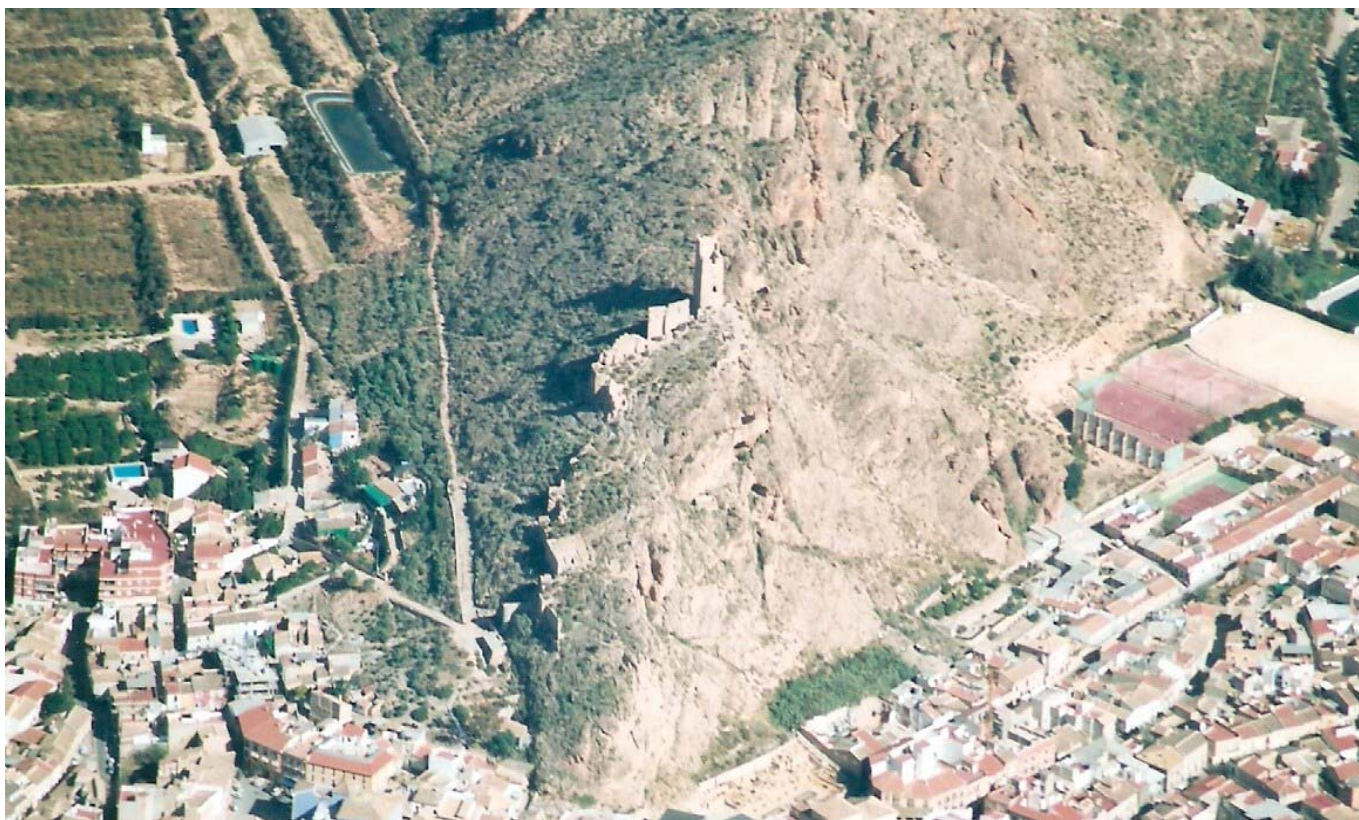
0144 – Desde el frente, se advierten el deterioro de las murallas de la parte baja del castillo (6-11-2002)
