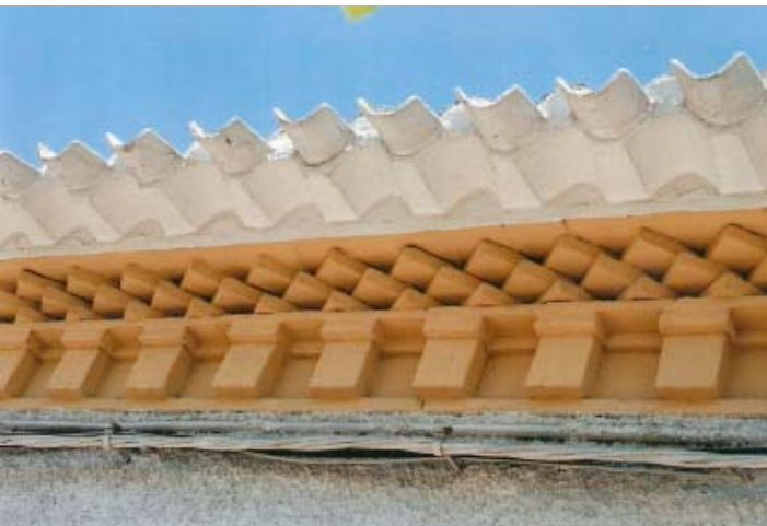
0262 – Edificio nº 39. Cornisa a base de ladrillos contrapeados (tipo 25) (27-8-2000)
