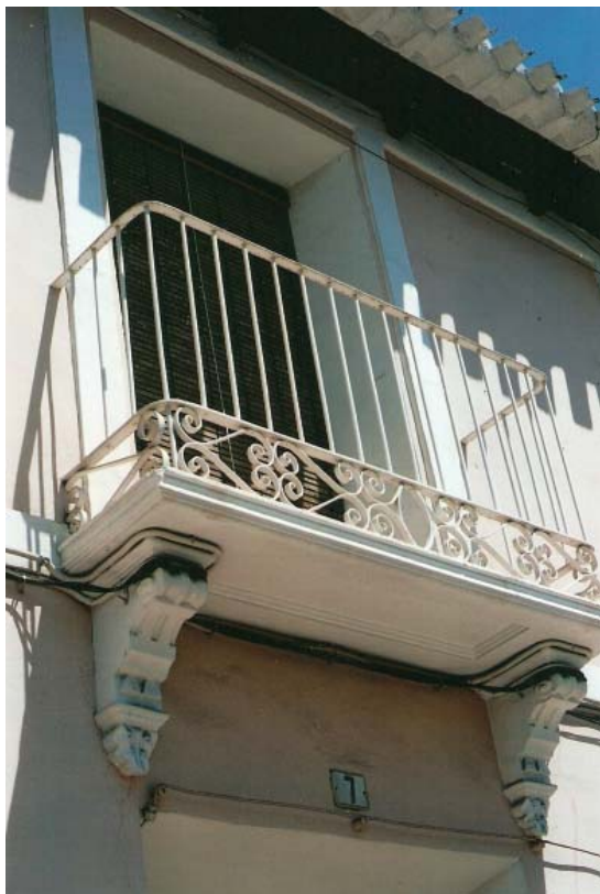
0433 – Edificio nº 7. Detalle del balcón con repisa y ménsulas de piedra artificial realizados en Alcantarilla o Murcia. Huevo con fajones (27-8-2000)
