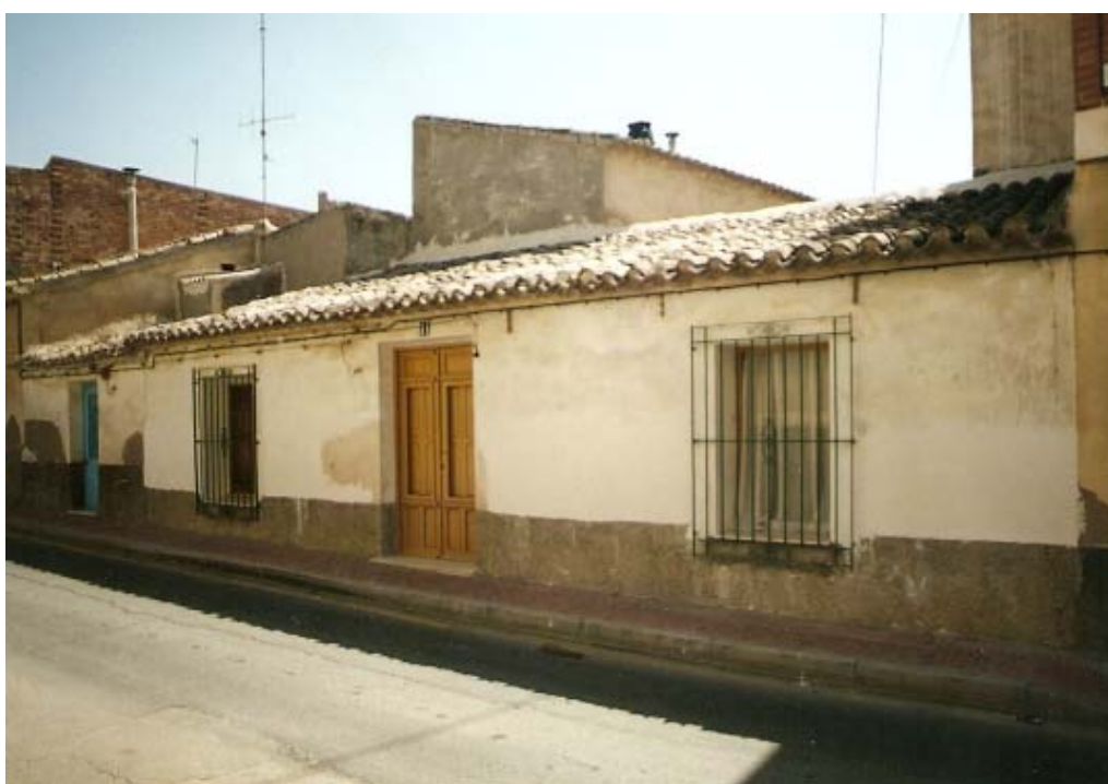
0424 – Edificios nº 9 y 11. Tipologías características (tipos I y III) reformadas en cuanto a huecos de fachadas (18-8-2000)
