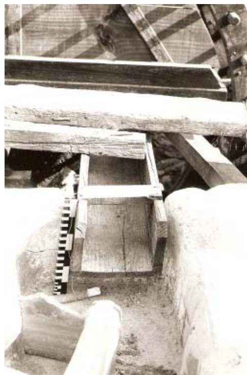
0216 – Salida del agua de la aceña por la artesilla que vierte a la acequia (15-9-1979)
