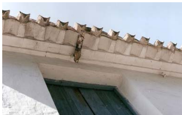
0225 – Edificio nº 18. Soporte sobre la ventana para enganchar la carrucha y poder introducir los productos agrícolas a los trojes de la algoifa. Carpintería de ventana original y cornisa simple (tipo 9) sobre hiladas de ladrillo (18-8-2000)
