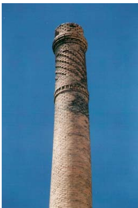
0454 – Cabeza de la chimenea con el anillo, la corona y la boquilla (20-9-2000)
