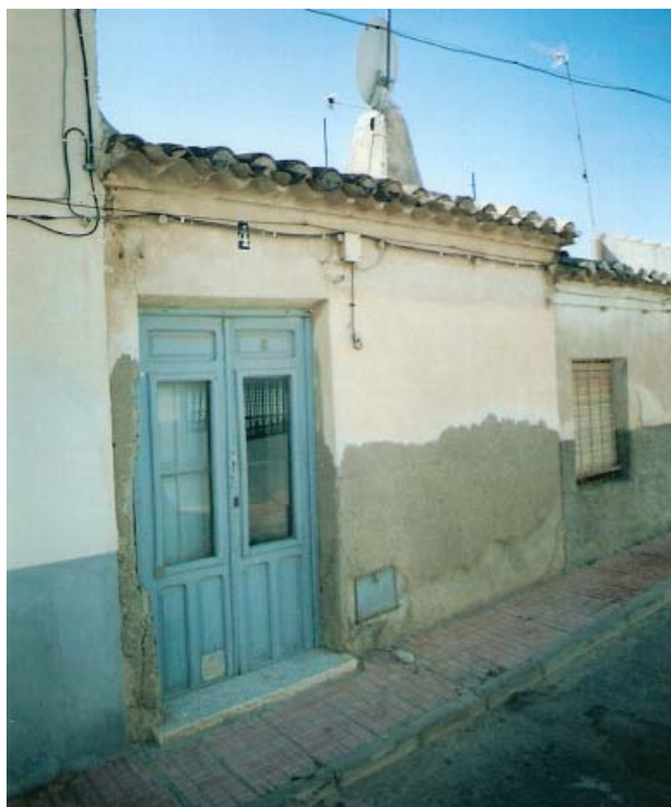
0415 – Edificio nº 4. Tipología característica (tipo I). Se ha sustituido la primitiva puerta (de tipo B o C a tipo F simple) (16-9-2000)
