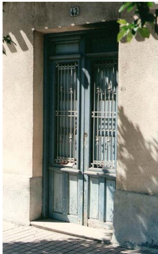
0266 – Edificio nº 42. Puerta de ventanillos, rejos y contraventanas simple (tipo F) (27-8-2000)
