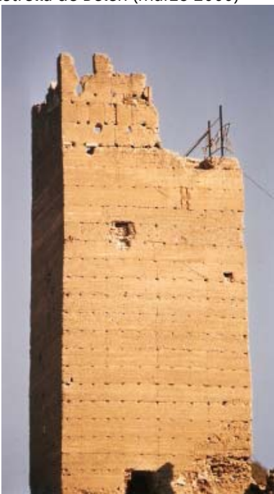
0165 – Alzado oeste de la torre, en donde existe una abertura que permite actualmente su acceso al interior. En su culminación queda constancia de la parte destruida. Los agujales del tapial son perfectamente visibles
