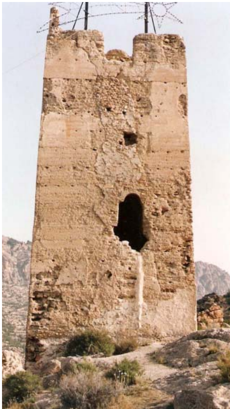
0163 – Alzado frontal o sur de la torre del homenaje. El acceso se sitúa a varios metros de altura y al que debería llegarse mediante una escalera de madera. Arriba permanecen los pies derechos metálicos que en su día, tras la guerra civil, sujetaron el yugo y las flechas, emblema de F.E.T. y de las J.O.N.S., y que ahora se han utilizado para instalar una estrella de Belén (marzo 2000)
