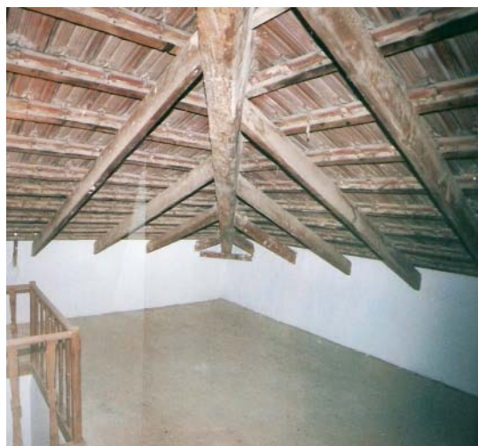
0246 – Interior de la torre con un pequeño desván o zaquizamí. Se aprecia el entramado de vigas y correas que sustentan la cubierta a base de tejas planas que se sujetan con alambre al listonaje (20-9-2000)
