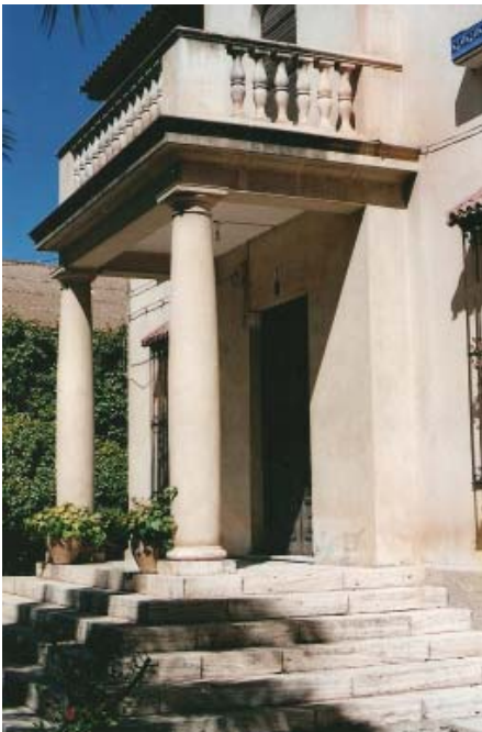
0322 – Alpende o alpendre de la entrada principal de la casa, formado por columnas de orden toscano y balaustres en la terraza superior (22-8-2000)
