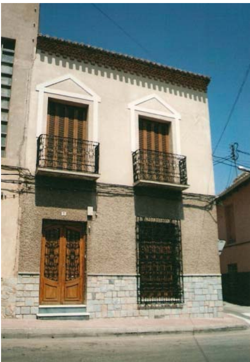
0427 – Edificio nº 5. Tipología característica (tipo V) pero muy alterada. Cerrajería y alero de una cierta elaboración con realización foránea (13-8-2000)
