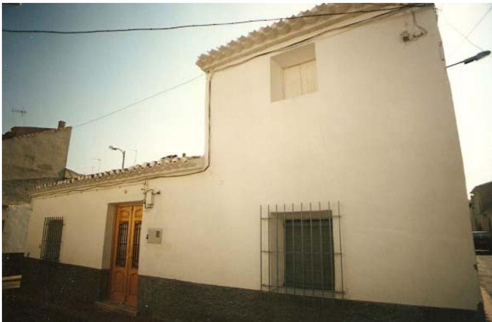
0228 – Edificio nº 5. Tipología característica (tipo II). Vivienda que presenta combinación de alturas en fachada, usando la planta superior de cámara o algarfa y manteniendo una carpintería original en ella. En la planta baja aparece una cerrajería superpuesta y la sustitución de la puerta de entrada a la vivienda (de tipo B a tipo F) (18-8-2000)
