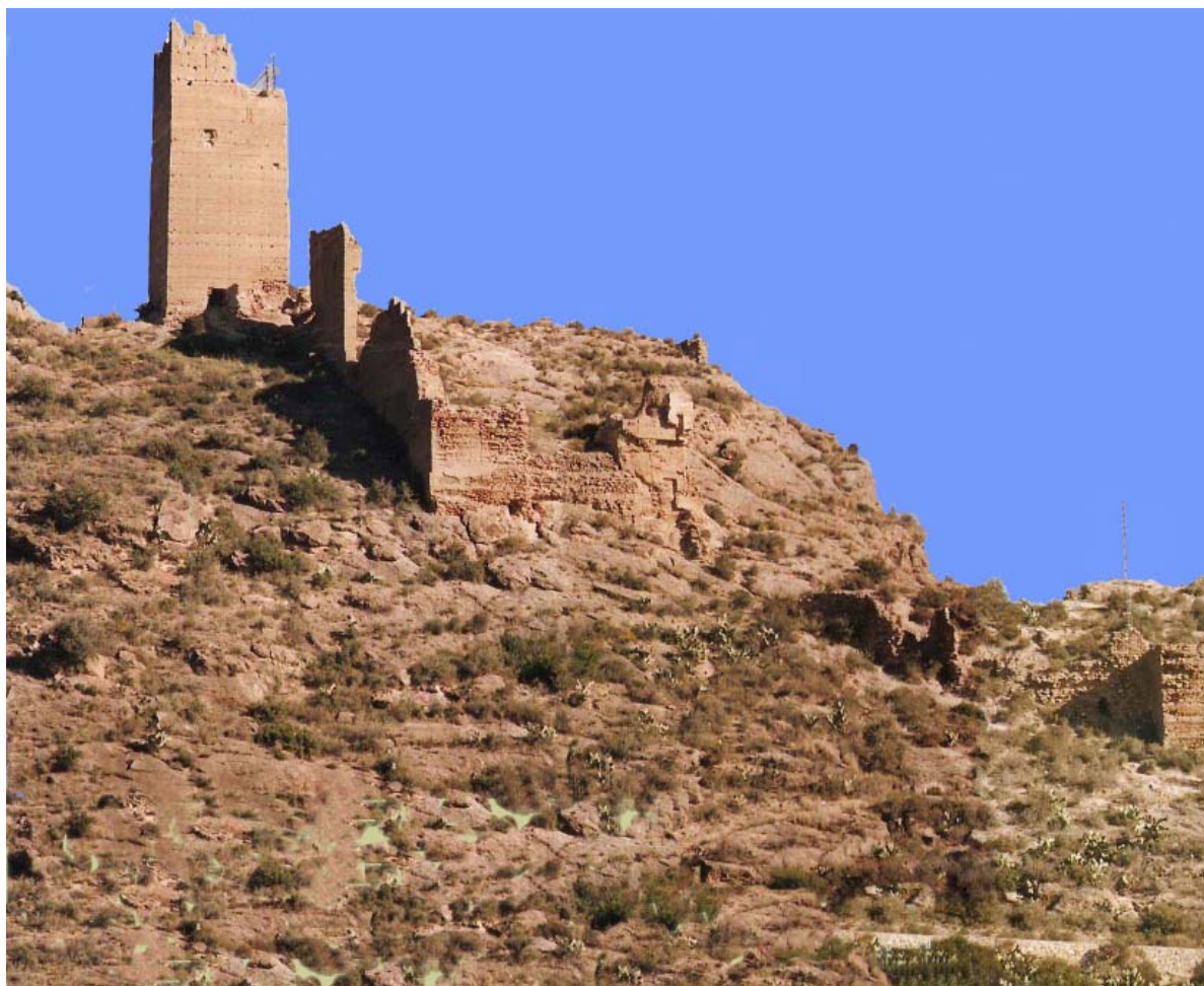
0149 – Vista lateral de toda la calahorra apreciándose la situación de ruina de buena parte de las murallas
