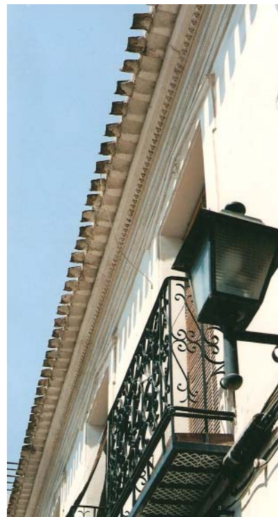
0361 – Edificio nº 12. Detalle de la repisa del balcón y del alero (13-8-2000)
