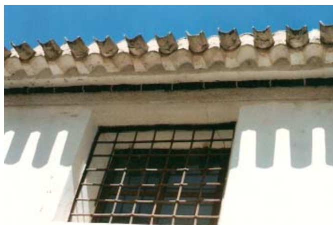
0286 – Edificio nº 8. Reja (tipo A) y alero simple (tipo 8) (22-8-2000)
