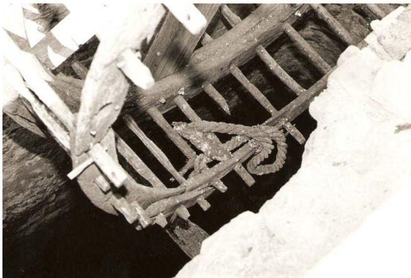
0215 – Rueda o andaraje con restos de las maromas a las que se ataban los arcaduces (15-9-1979)
