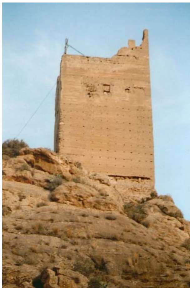
0166 – Alzado de la torre por su parte este (junio 2000)
