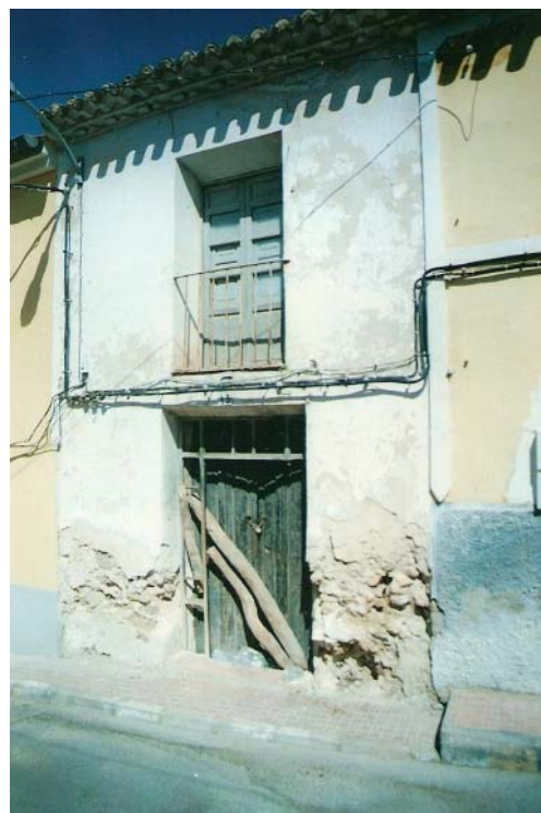
0307 – Edificio nº 13. Tipología característica (tipo I). Vivienda que mantiene su puerta original (tipo C). En la planta alta posiblemente se realizase un balcón partiendo de un ventanuco de la cilla (16-9-2000)
