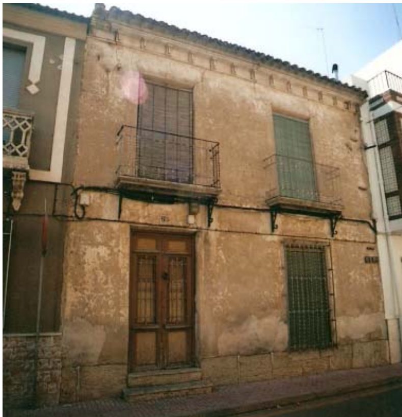
0381 – Edificio nº 29. Tipología característica (tipo V) con puerta de ventanillos (tipo F) y cerrajería uniforme en los huecos (tipo C) (13-8-2000)
