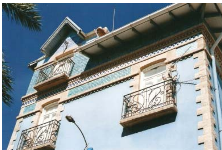
0236 – Planta alta y torre en la fachada principal. Cerrajería modernista y faja de piezas vidriadas bajo el alero con canalera sujeta con fiadores o escarpadores (20-9-2000)
