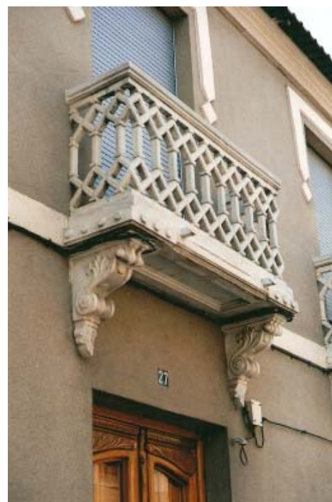
0376 – Edificio nº 27. Detalle del balcón prefabricado en piedra artificial (modelo muy usado y todavía existente en edificios de Alhama, Murcia y otras poblaciones) (13-8-2000)
