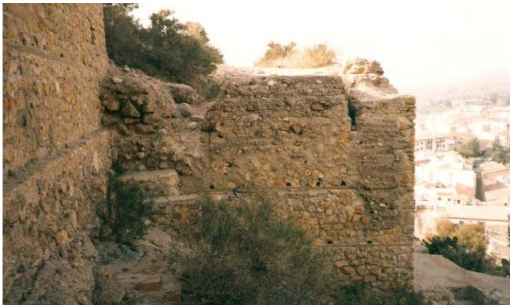
0156 – Tramos de muralla parcialmente restaurados empleando técnicas de tapial. Pueden apreciarse los orificios de los agujales (marzo 2000)
