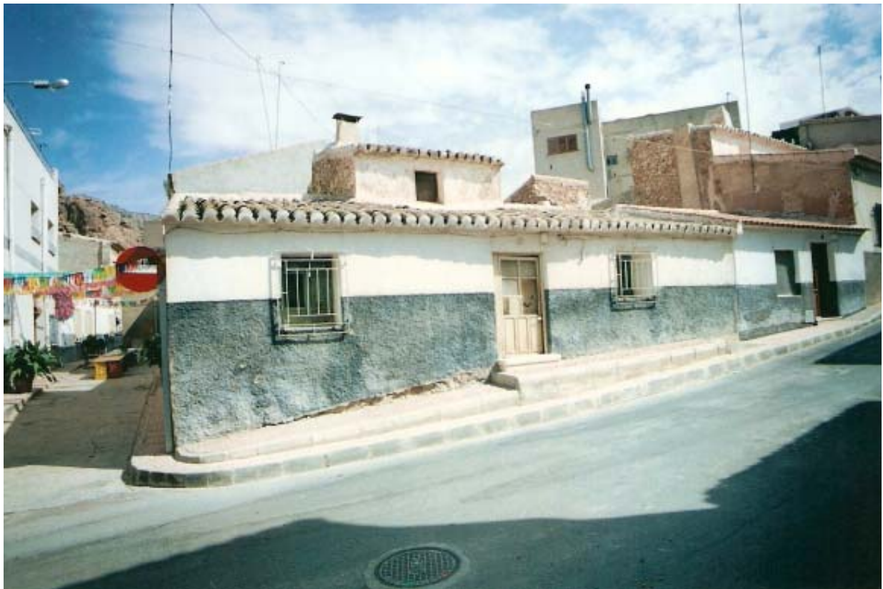
0301 – Edificio nº 17. Tipología muy característica (tipo III). Presenta la carpintería (original tipo A o B) y la cerrajería sustituidas (17-9-2000)
