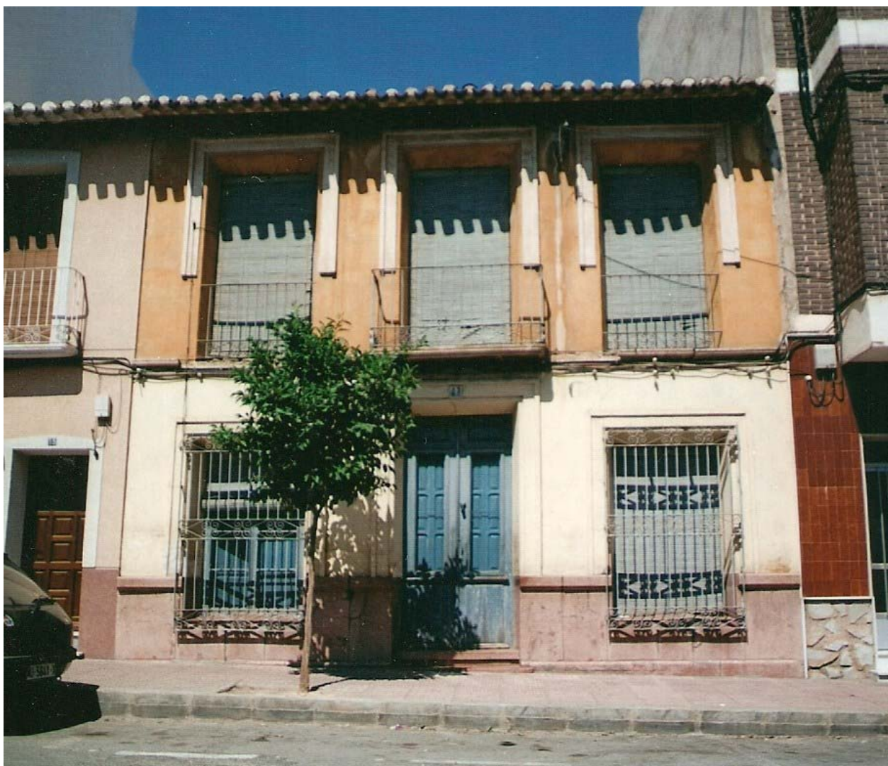
0435 – Edificio nº 17. Tipología característica (tipo V) de edificación en las nuevas carreteras de acceso a la población (15-8-2000)
