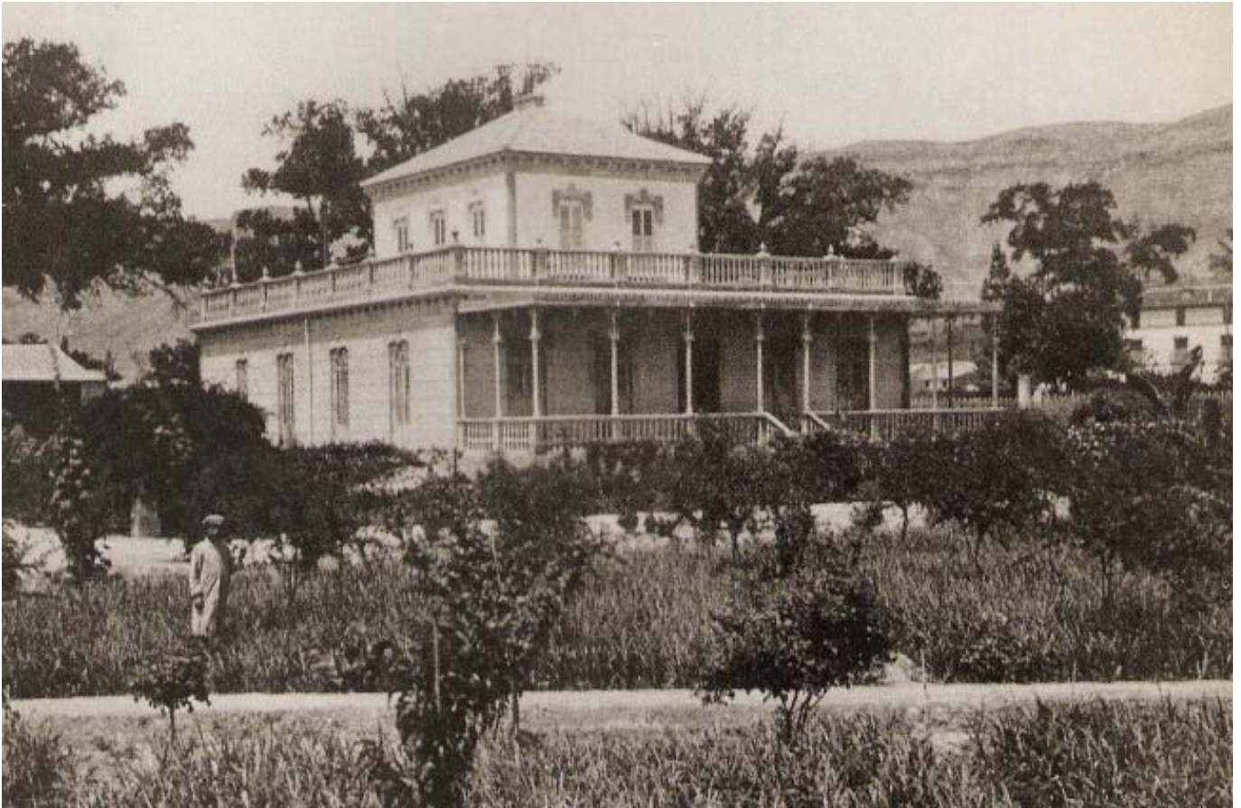
0390 – Casa de Lorenzo Rubio Sánchez (Alhama 1878-Santiago de Cuba 1953). Edificio ecléctico de un gran valor histórico y cultural para Alhama que fue lamentablemente derribado para construir en su solar la actualmente llamada Casa de la "Cultura". No puede existir mayor contradicción (ver: "Cien años de historia de Alhama en imágenes" de Mateo García Martínez y "La casa de Don Lorenzo Rubio" en el periódico "Crónicas de Alhama", nº 209, por Pedro Cascales) (archivo Mateo García, Ángel Martínez, años 10)
