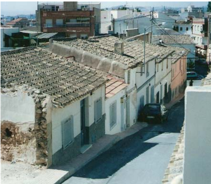
0500 – La calle de la Ferrela reúne unas características propias en cuanto a tipologías constructivas se refiere. En esta zona abundaban hasta hace unos años las casas de terrado. Una de ellas era la segunda que se aprecia en la fotografía. Puede también apreciarse la estructura del muro de mampostería situado en el solar de la izquierda (16-9-2000)
