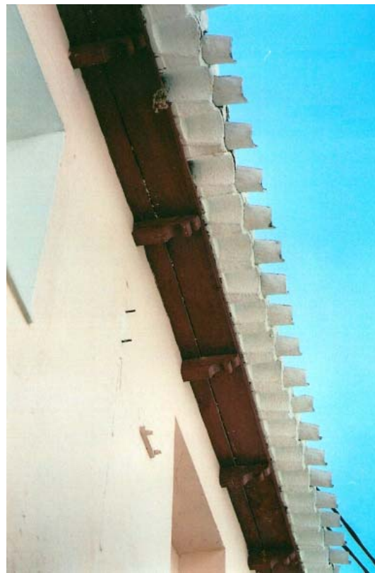
0434 – Edificio nº 7. Alero de madera con canecillos (tipo 2) (16-9-2000)
