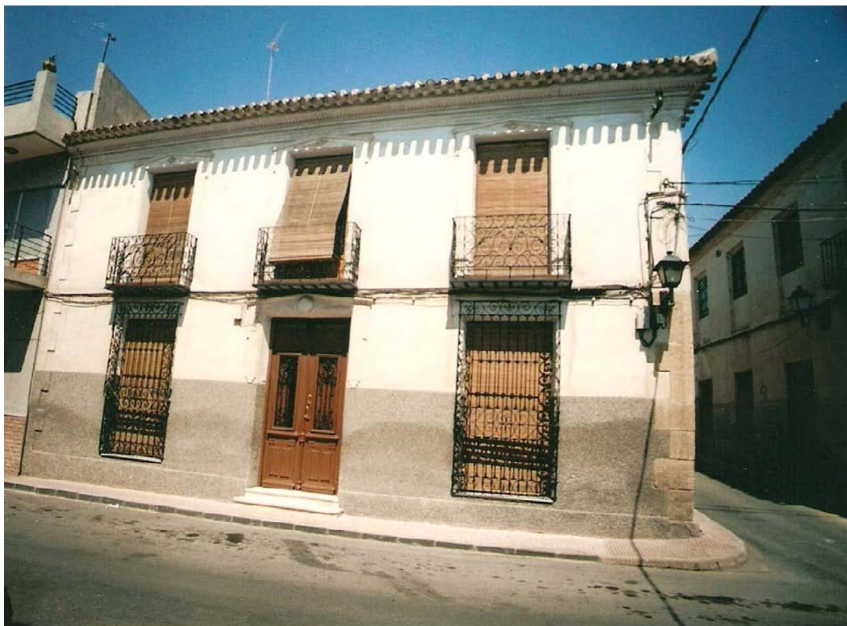
0357 – Edificio nº 12. Tipología característica (tipo V). Destaca la cerrajería, posiblemente sustituida, balcones y carpintería (13-8-2000)
