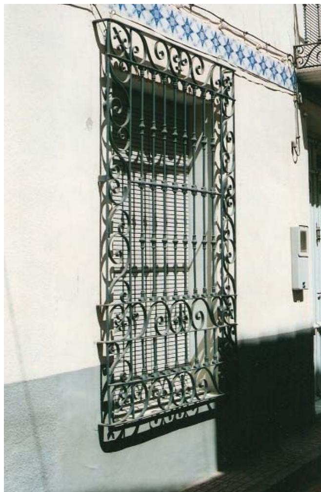
0284 – Edificio nº 2. Reja (tipo B) (22-8-2000)
