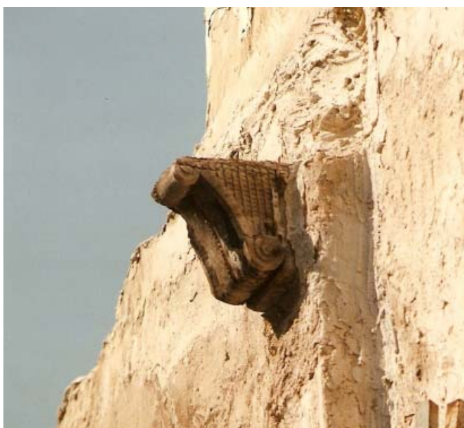
0309 – Edificio nº 8. Al derribar la construcción queda una de las ménsulas de la viga de carga de la vivienda, propia del siglo XVIII (18-8-2000)
