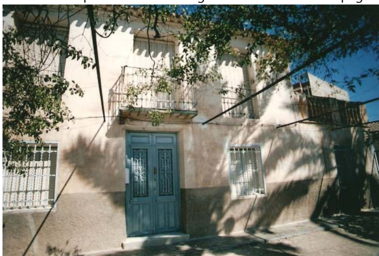
0272 – Fachada con puerta de ventanillos (tipo F) y cerrajería clásica de perfiles trenzados (tipo C). En los laterales aparecen, de forma simétrica, terrazas con antepechos realizados a base de aparejos de ladrillo (27-8-2000)
