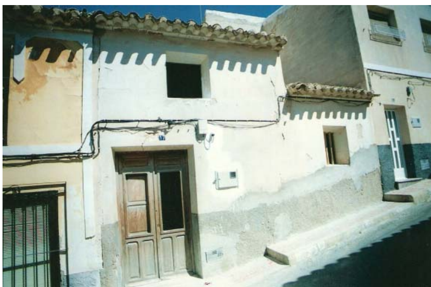
0306 – Edificio nº 17. Tipología característica (tipo I). La puerta de entrada ha sido sustituida (de tipo B a tipo F) con ampliación de hueco. Mantiene los palos de la ventana. Resulta interesante el concepto volumétrico en dos alturas (16-9-2000)
