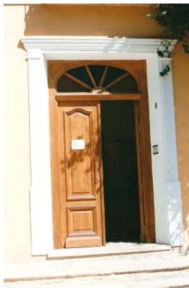
0278 – Puerta de entrada moderna (tipo E) con escalinata a base de losas de cantería original (22-8-2000)
