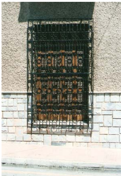
0430 – Edificio nº 5. Reja de la ventana de la planta baja (27-8-2000)
