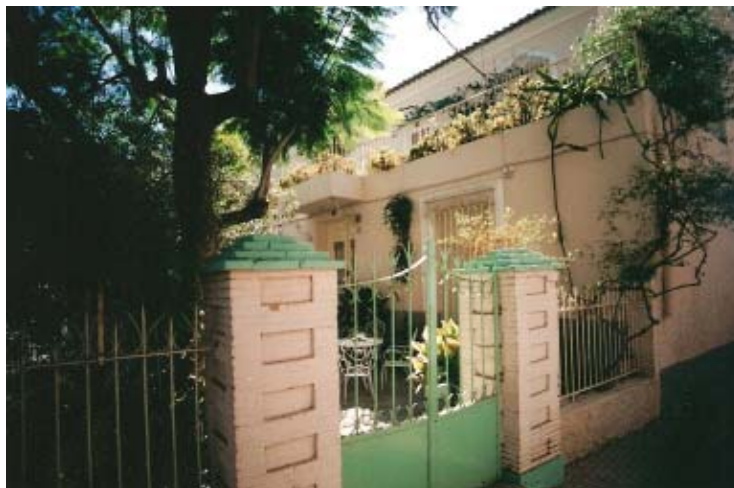
0329 – Edificio nº 23. Construcción de transición al medio rural, con terraza antepuesta a la planta alta en zona entonces colindante al núcleo urbano. Puertas de cancela al espacio ajardinado con postes de ladrillo (22-8-2000)
