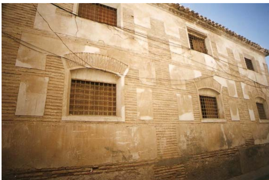
0289 – Casa de La Tercia. Fachada trasera. Construcción clásica del siglo XVIII con muros de cerramiento a base de mampostería y verdugadas de ladrillo. Alero con cornisa simple (tipo 21) (18-8-2000)
