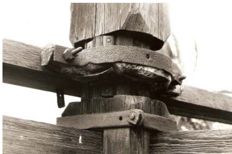
0203 – Golilla en la unión del eje de la aceña al "hubio" (15-9-1979)
