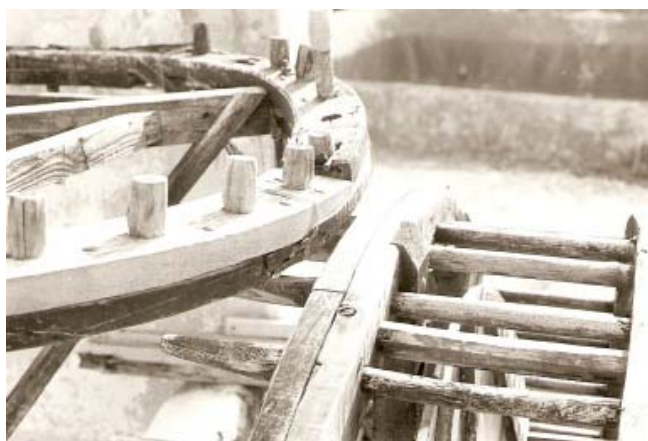
0207 – Engrane de los puntos de la "contrarrueda" con el andaraje o rueda de los arcaduces (15-9-1979)
