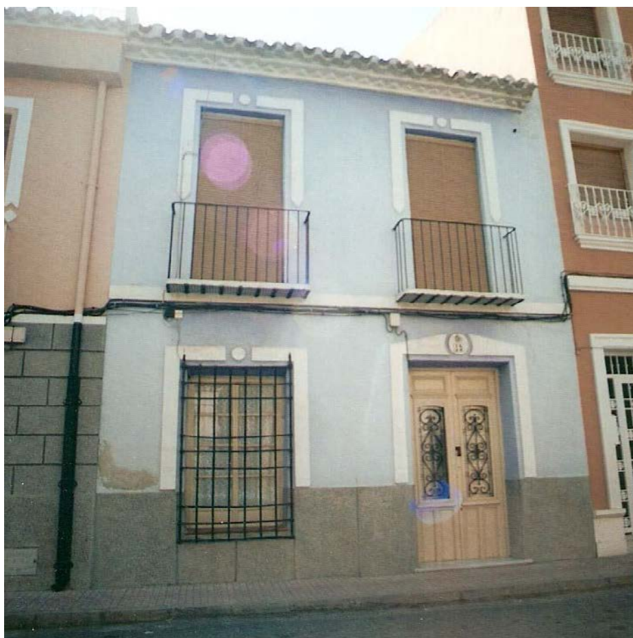
0363 – Edificio nº 15. Tipología característica (tipo V). Construcción con revestimientos restaurados pero manteniendo sus elementos originales de reja (tipo A) y balcones posteriores de repisa de plantilla y baldosas. Cerco o fajón decorativo en los huecos en fecha posterior así como la puerta de entrada (tipo F) (15-8-2000)
