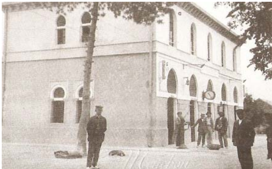
0456 – Edificio de la antigua estación del ferrocarril. La línea de Alcantarilla a Lorca fue inaugurada el día 28 de marzo del año 1885 (Rodrigo Menchón, años 20)
