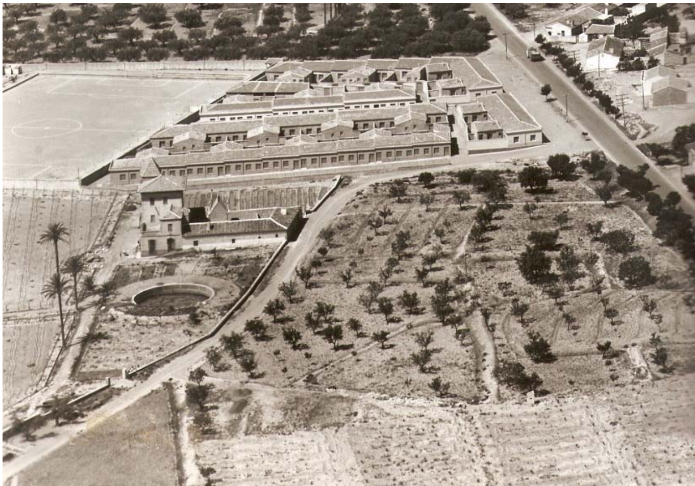
0083 – El nuevo grupo de viviendas protegidas corta el que fue camino medieval de El Chapado o de La Algodonera de acceso a la población desde Murcia por el camino Real o de La Torre. En primer término la casa y balsa de La Algodonera. A la derecha el Ventorrillo de Manuel, propiedad de Josefa García, cuya casa preside el hoy Jardín de Los Patos (Paisajes Españoles 15-5-1962)
