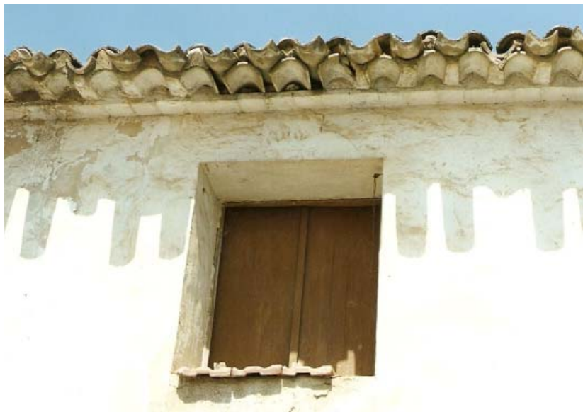
0421 – Edificio nº 6. Detalle de la ventana de la planta alta y la simplicidad del alero (tipo 8) (18-8-2000)
