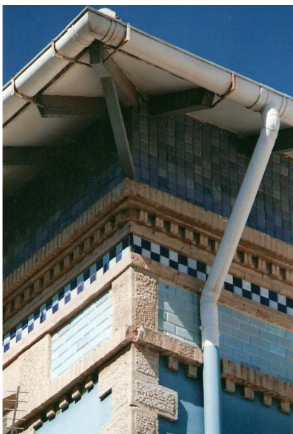
0241 – Cornijón de la edificación y elementos del alero con los canecillos y las canaleras para la captación de agua para el aljibe (20-9-2000)
