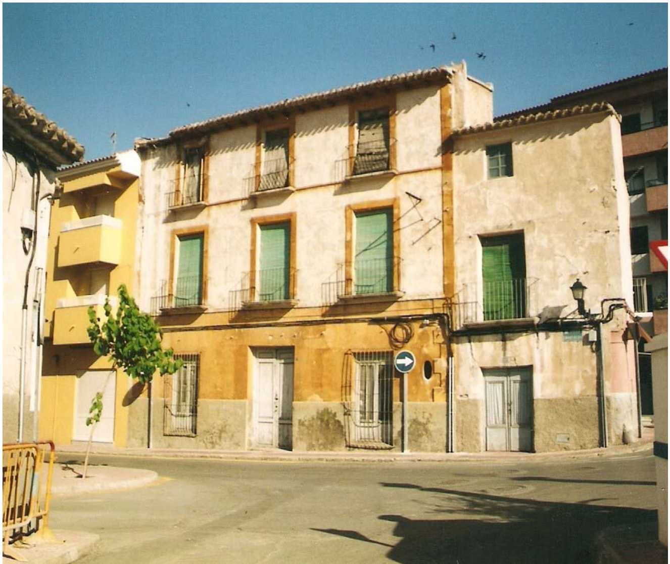
0389 – Edificio nº 35. Casa de Ferragut. Tipología característica (tipo V), con la singularidad de utilización de una tercera planta. Mantiene su carpintería y cerrajería originales. Fajones en los huecos y alero de madera (tipo 4) (15-6-2001)
