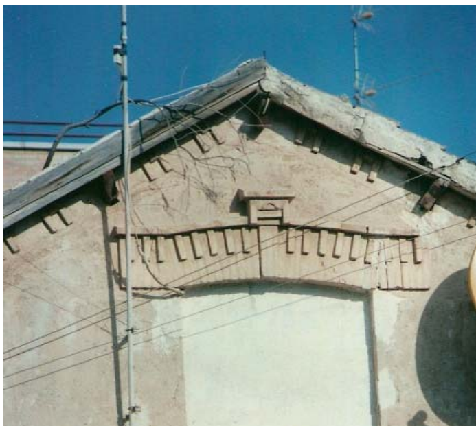
0400 – Hastial y fachada sur del almacén (18-9-2000)
