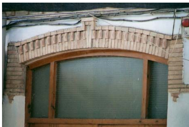
0401 – Puerta del almacén (18-9-2000)
