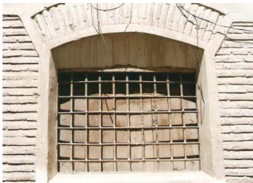
0291 – Casa de La Tercia. Detalle de ventana con reja (tipo A) de la planta baja y arcos con derrame (22-8-2000)
