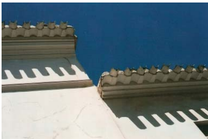
0283 – Edificio nº 2. Cornisa (tipo 15) (22-8-2000)
