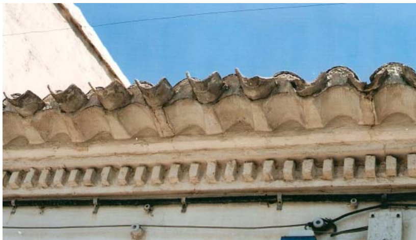
0270 – Edificio nº 45. Cornisa (tipo 15) (27-8-2000)
