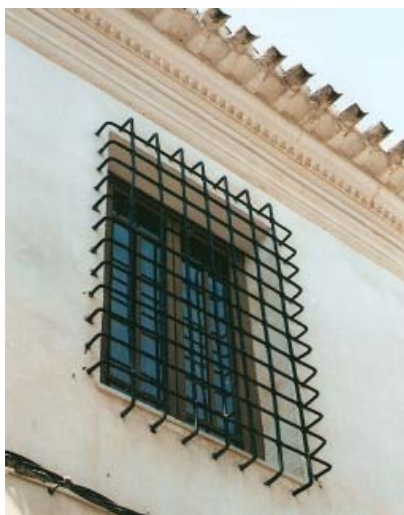
0362 – Edificio nº 12. Reja en fachada lateral (tipo A) posiblemente original (13-8-2000)
