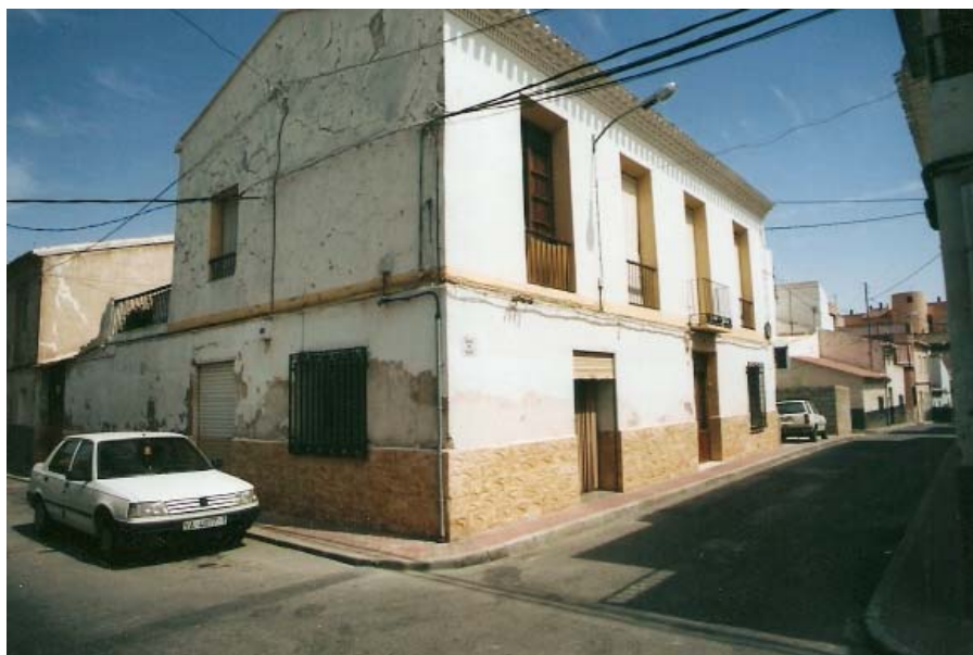
0230 – Edificio nº 6 esquina a la calle del Molino. Construcción con patio posterior y entrada independiente al mismo. Se mantienen las características de los huecos superiores pero se abre entrada para actividad comercial en planta baja y se adaptan rejas de otras procedencias (6-8-2002)
