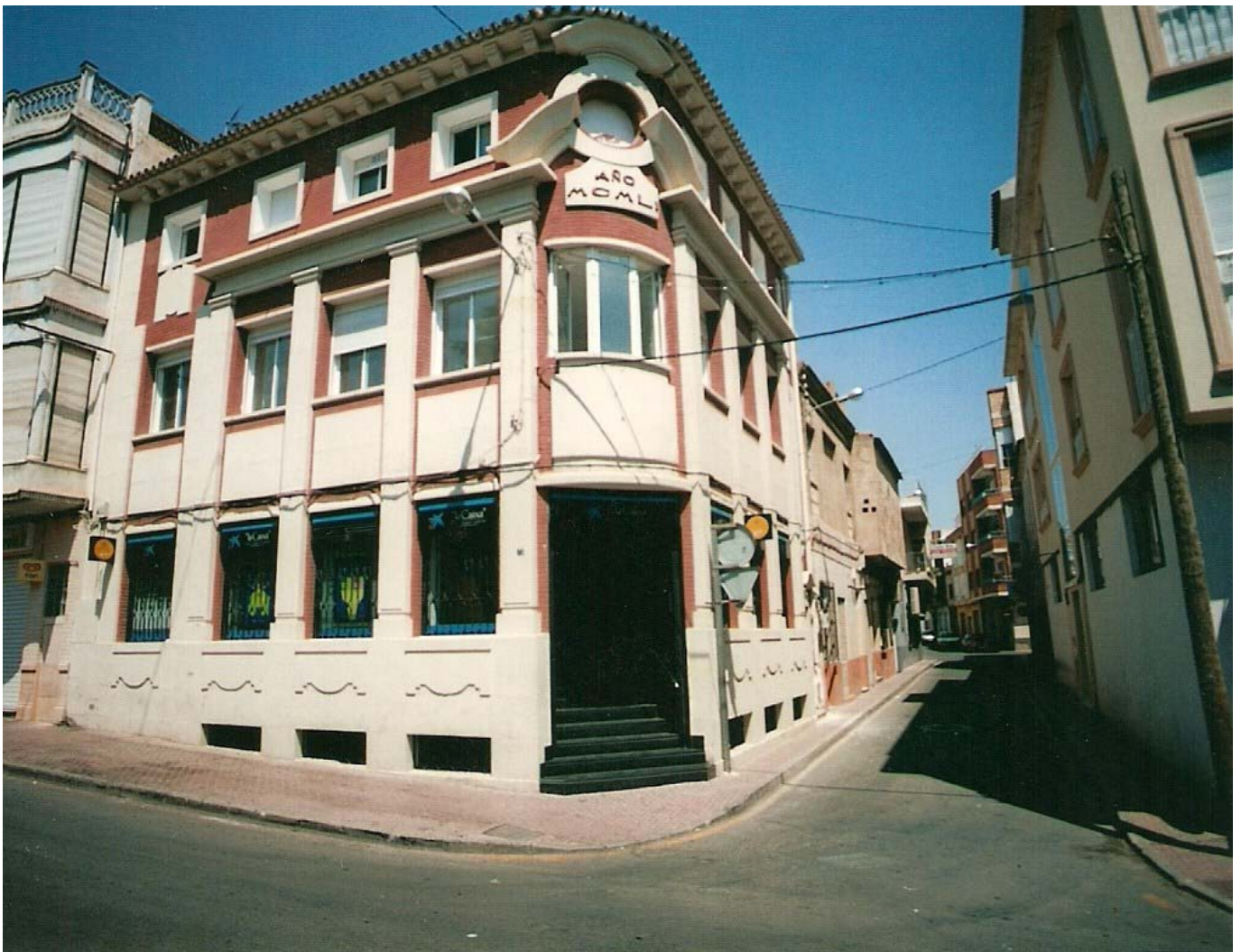
0498 – Edificio de la entonces Caja de Ahorros, ahora ocupado por la catalana Caixa y construido en el año 1951 según consta en la fachada (13-8-2000)
