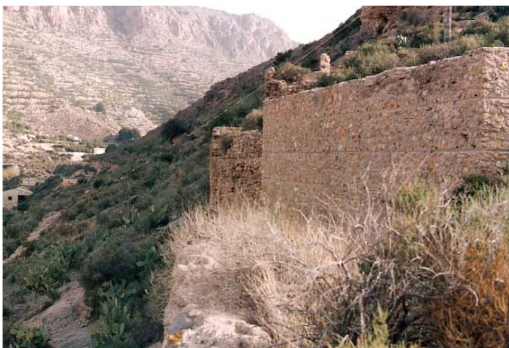
0158 – Vista de parte de la muralla desde una de las torres (marzo 2000)
