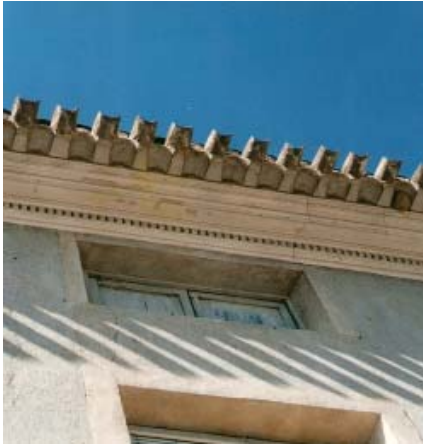
0442 – Edificio nº 20. Detalle de la cornisa con denticulos (tipo 37) y ventana de la cámara (27-8-2000)
