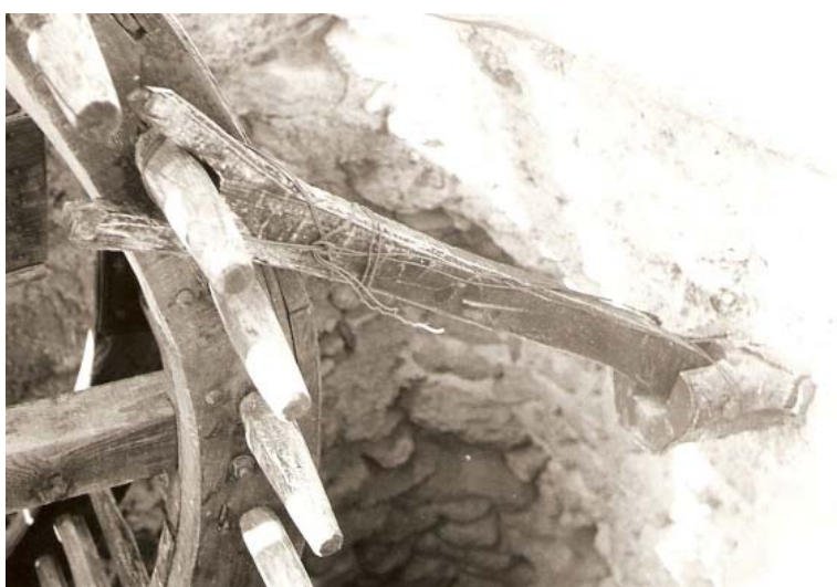
0212 – Mástil o eje de la rueda andaraje o de arcaduces y su encuentro con las cruces (15-9-1979)
