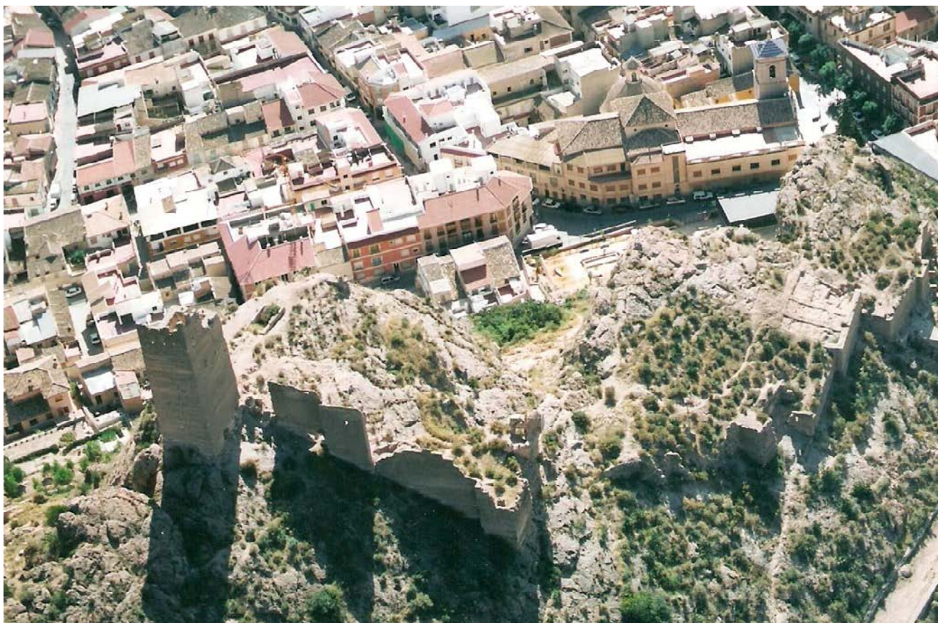
0146 – En esta fotografía puede apreciarse la situación de la torre sobre las edificaciones más inmediatas de la población y el estado de las murallas. Puede verse también la zona excavada (6-11-2002)
