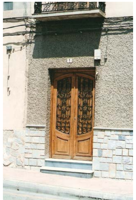
0428 – Edificio nº 5. Detalle de la puerta de ventanillos con sus rejos y contraventanas (tipo F) (27-8-2000)
