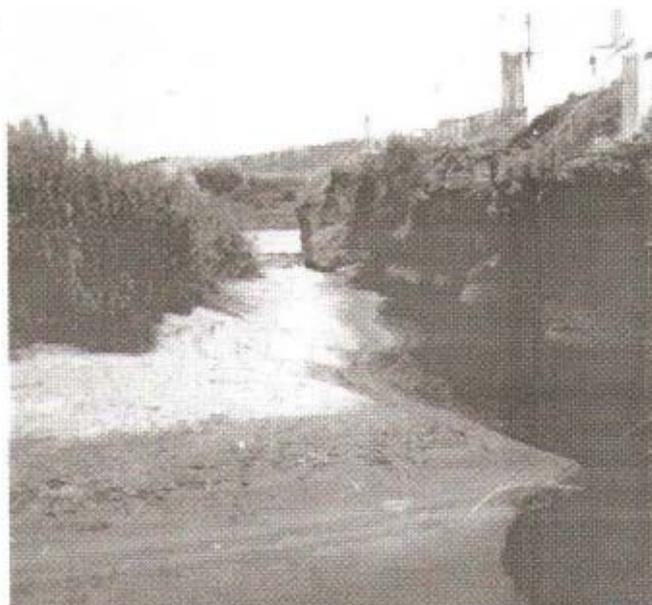
Fig.51- Pared rocosa en que se apoya la presa
