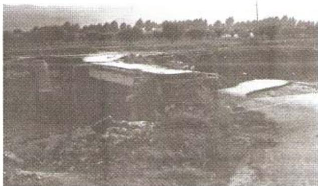
Fig. 28- Estado en que quedó el puente de la Carretera de Sangonera la Verde a Era Alta sobre el Guadalentín tras la riada de 1973.
